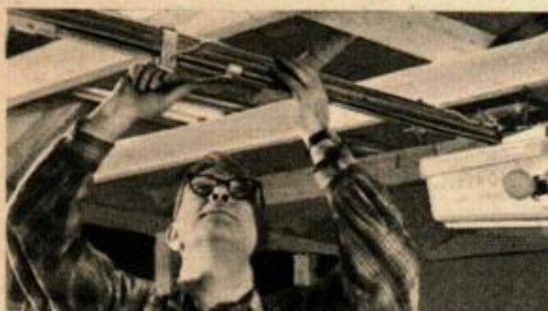
Un tube noir (ci-dessus) empêche la lumière ambiante d'activer le dispositif. Des contacts de limitation de course (ci-dessous) sont montés sur les rails de guidage de la porte.
