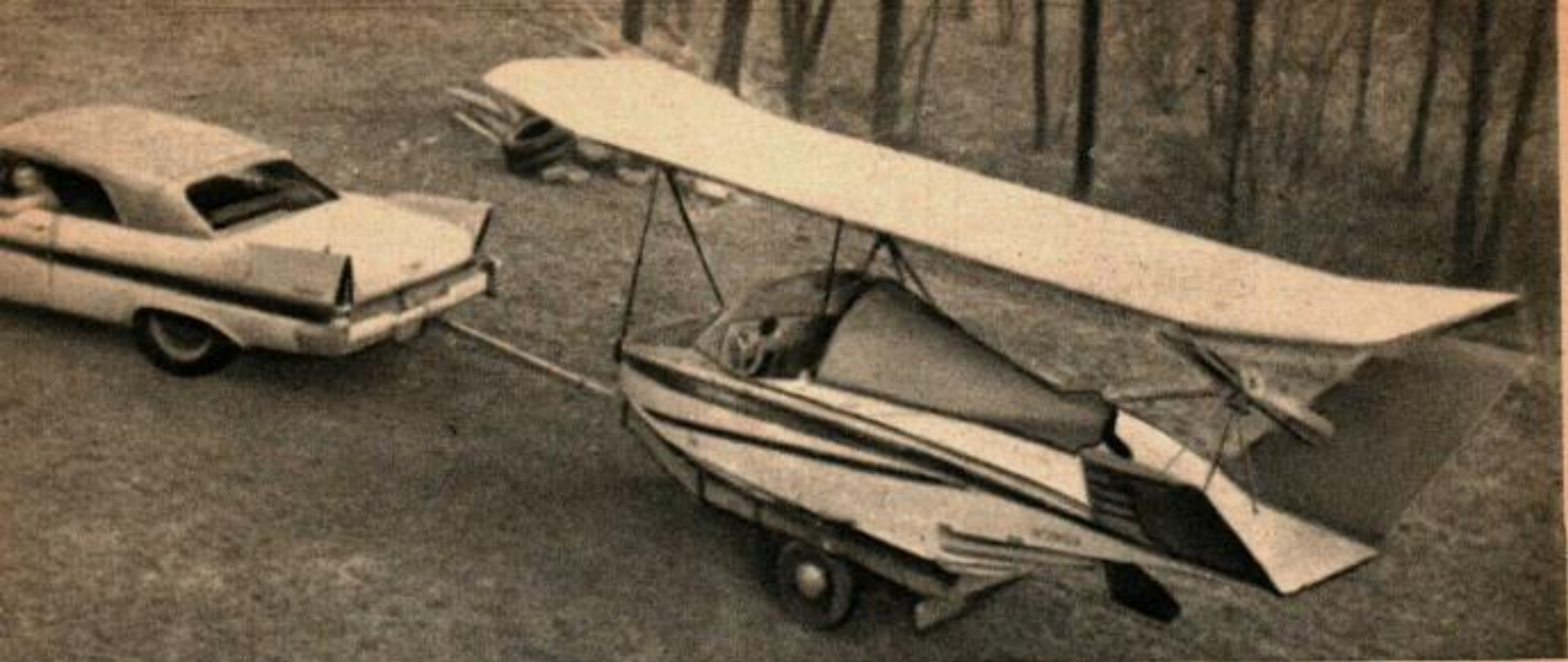
En route vers les voies navigables, l'aile du Wing Dingy est rabattue parallèlement à la coque, et le bateau se transporte en remorque comme n'importe quel autre.
