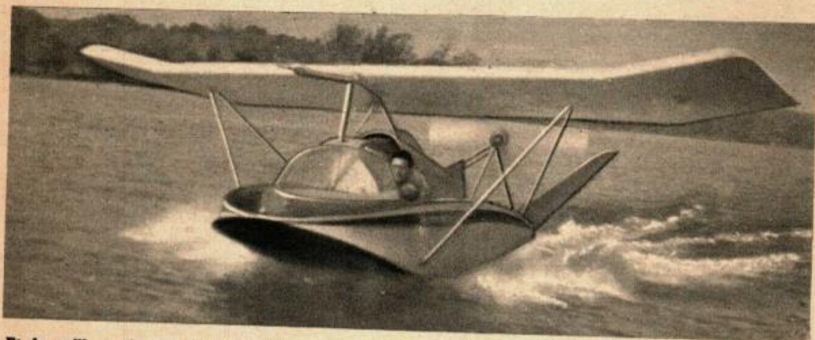
Et le voilà parti ! L'hélice arrière pousse le Wing Dingy à travers l'eau. Lorsque la vitesse atteinte est suffisante, il décolle.
