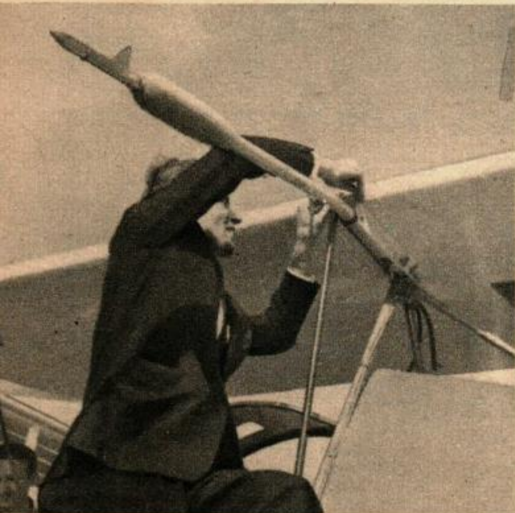
Le tube de Pitot, monté sur l'aile directement au-dessus de l'habitacle, fait partie de l'équipement standard de l'appareil. L'admission d'air est convertie en vitesse aérienne, indiquée par le compteur de vitesse aérienne dans le cockpit.
