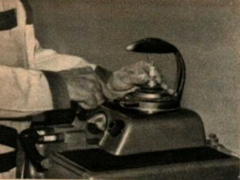
8. LES MECANICIENS PROFESSIONNELS nettoient les bougies au jet de sable sur des machines telles que celle représentée ici. Ce genre de machine effectue un travail de nettoyage parfait.
