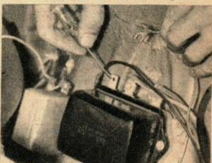
10. DES BRANCHEMENTS électriques propres sont essentiels dans un câblage. Prenez le temps d'effectuer un travail de nettoyage parfait.
