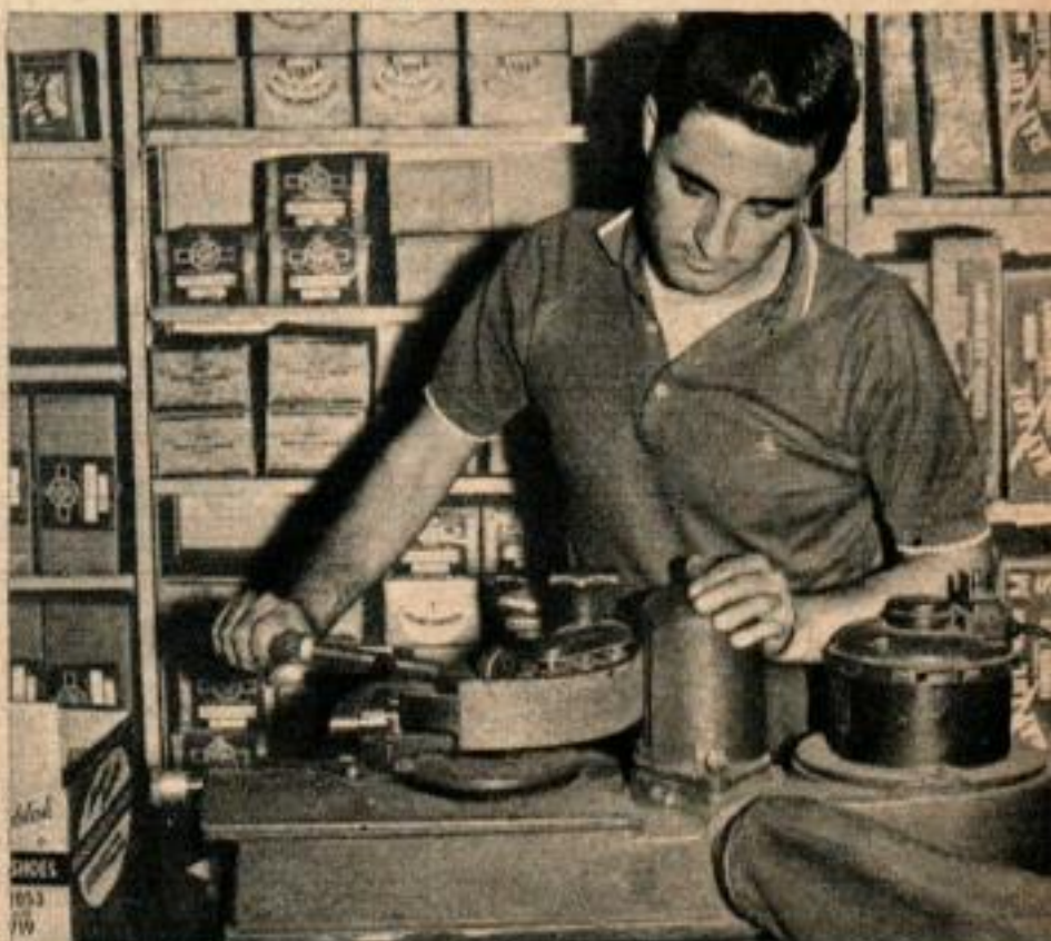
4. Les garnitures de frein sont incurvées en concentricité avec les tambours sur une machine spécialement conçue à cette fin.
