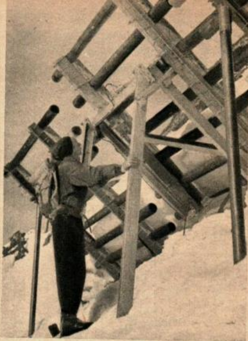
Cette barrière à neige expérimentale destinée à prévenir les avalanches, est l'une des diverses variétés en cours d'essai au Weissfluhjoch, en Suisse.
