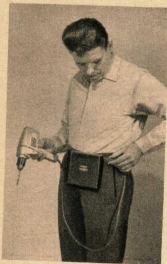
Cette perceuse est entraînée par un « groupe de force » attaché à la ceinture de l'opérateur. Elle fonctionne avec toute sa puissance étalonée.
