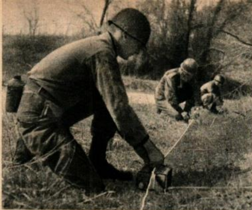
Des mines au napalm, chargées d'essence et de poudre épaississante, sont enterrées et allumées avec un nouveau détonateur, arrosant les soldats ennemis de liquide enflammé.
