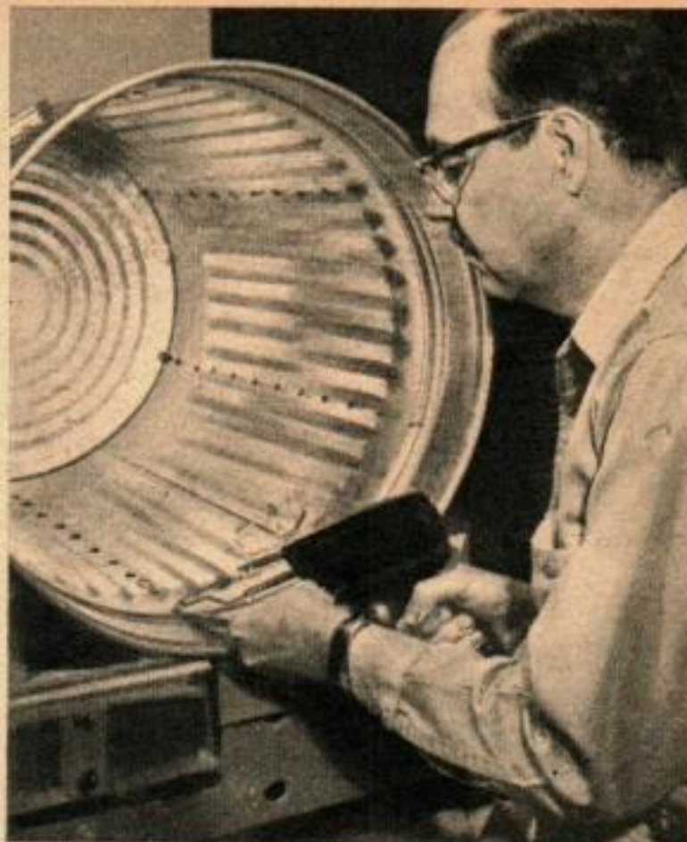
11. Le ruban de chauffage, ci-dessus, est branché dans la prise extra-plate. A droite, application des points de soudure sur l'intérieur de la poubelle.
