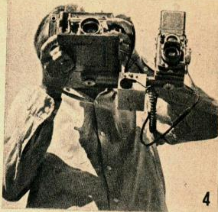
Si vous désirez prendre simultanément des clichés en couleur et des clichés en noir et blanc, vous pouvez monter un deuxième appareil sur une barre fixée sur le premier, et fixer la boîte entre les deux.
