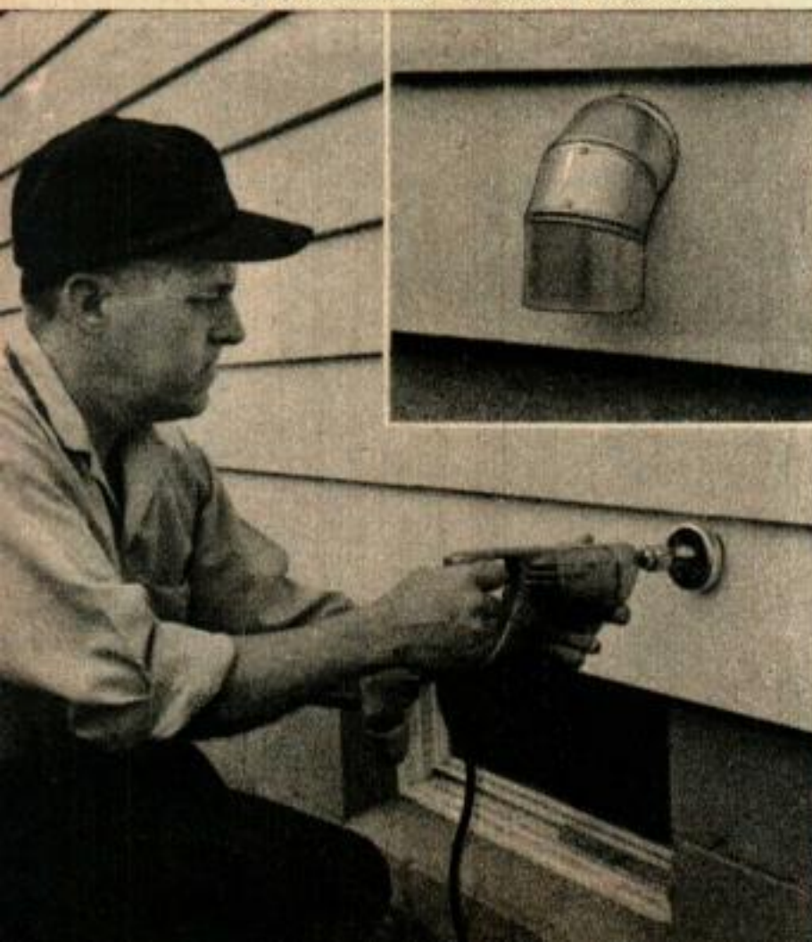
4. Une scie à trous est utilisée pour percer à travers le mur de la maison l'ouverture pour l'évent extérieur de la canalisation. L'évent doit être protégé par un capuchon de quelque sorte, par exemple le tuyau d'aération représenté ci-dessous.
