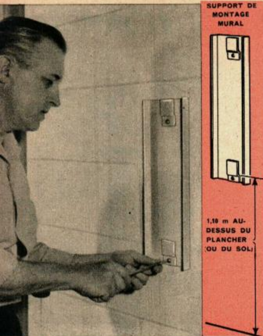
3. Le groupe de force est suspendu sur le mur au moyen de ce support de montage en acier qui est disposé, par rapport au sol, à l'exacte distance indiquée sur le schéma ci-dessus.
