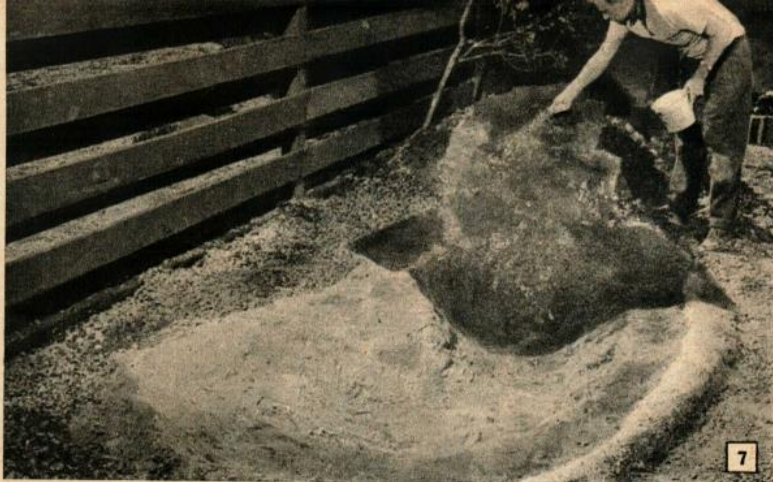
7. Une surface texturée s'harmonisant avec le sol est créée en saupoudrant la dernière couche de résine synthétique avec du sable à gros grains.
