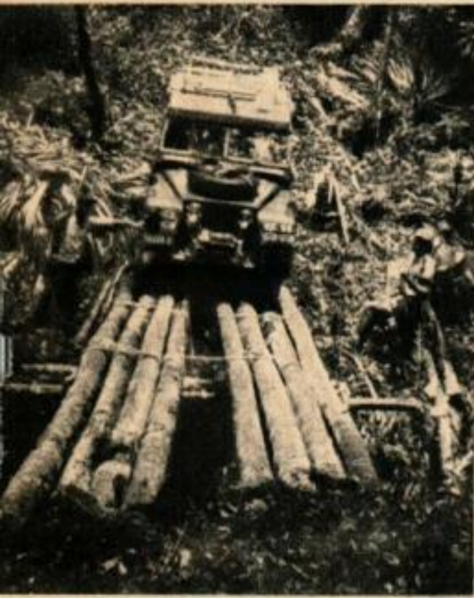
Ceci est l'un des cent vingt-cinq ponts en troncs de palmier construits par l'équipe de l'expédition par le travers des ravines de la jungle.
