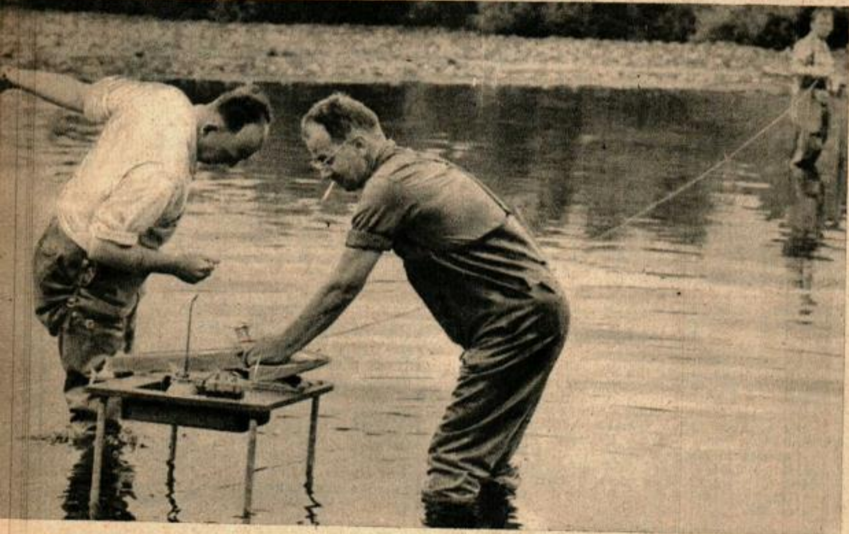
Sillage et patageage. Filant à près de 130 km/h, l'hydroglisseur de 45 cm, ci-dessus, projette la même écumante « queue de coq » qu'un engin de course de 9 m. Trois constructeurs, ci-dessous, mettent en marche un moteur qui peut tourner à 18 000 tr/mn.
