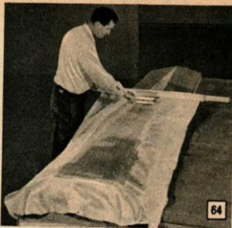
Le tissu de fibre de verre est déroulé du tube sur la coque enduite de résine, tout en éliminant les plissements avec le rouleau.
