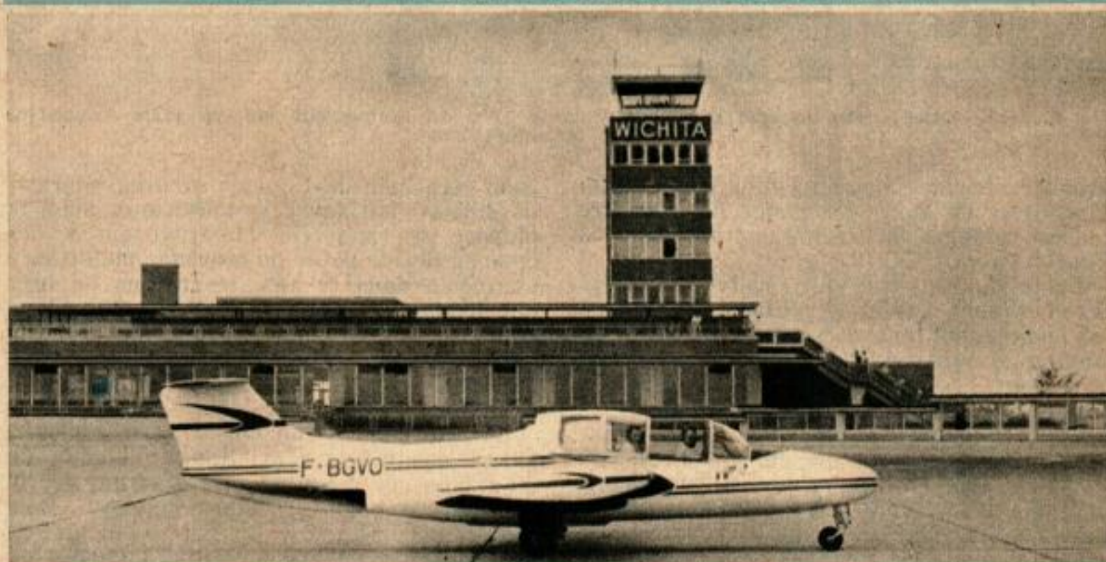
L'appareil à réaction français Morane-Saulnier type 760 fut le premier avion à turbo-propulseur à se joindre à la flotte des avions pour hommes d'affaires américains lorsqu'il fut importé par la Beech Aircraft Corporation. Le M-S 760, un appareil pressurisé à quatre places, peut atteindre des vitesses de l'ordre de 645 km/h.
