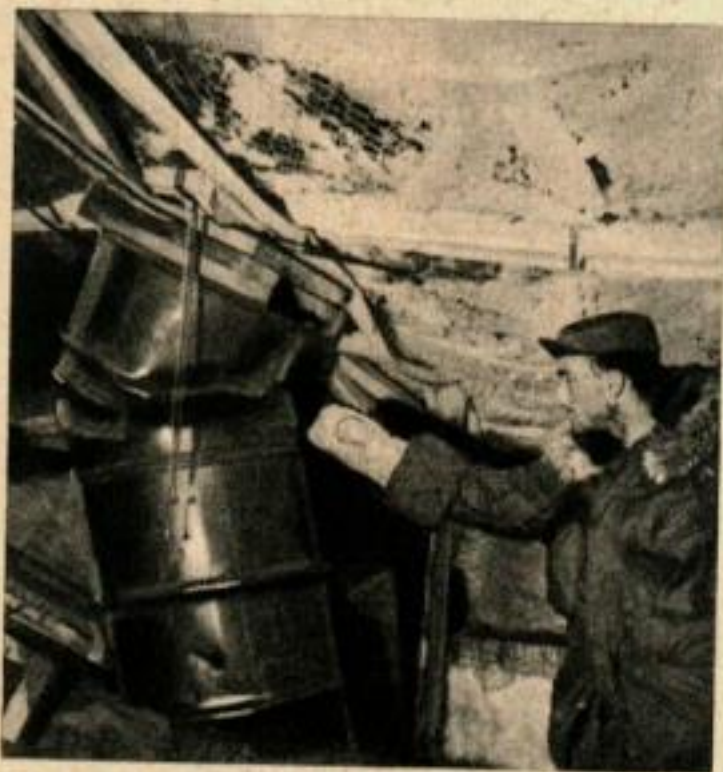
L'épaisse accumulation de neige au-dessus des bâtiments de la base de Byrd a amorcé des affaissements. Même les colonnes faites de tonneaux à huile soudés plient sous le poids de 4,50 m de glace et de neige.
