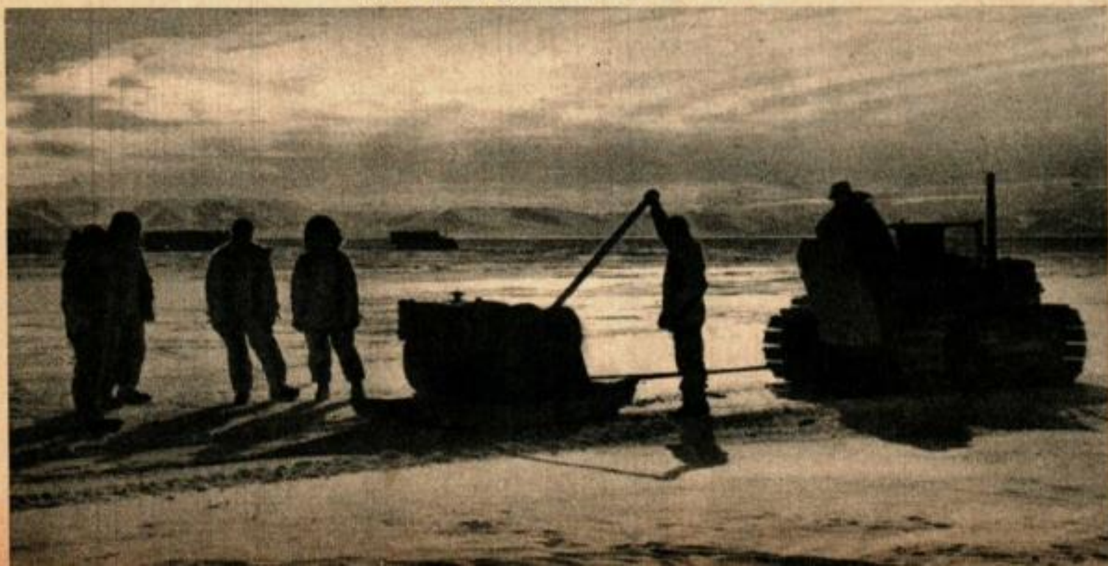
Un tracteur tire une géante scie à chaîne qui tranche les 3 m d'épaisseur de la glace pour découper dans celle-ci des « quais » destinés à d'autres navires.
