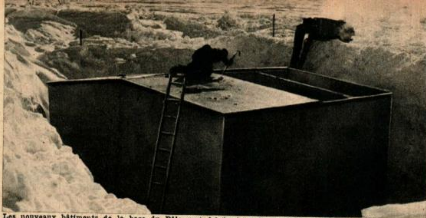
Les nouveaux bâtiments de la base du Pôle sont érigés dans de profondes fosses. Puis de la neige est tassée au-dessus d'eux avec des bulldozers de façon à obtenir une surface nivelée ne se prêtant pas à l'amoncellement en congères.
