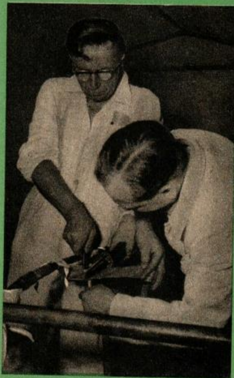
Ce poseur de câble barbu enroule du fil métallique de blindage autour d'une épissure. Ci-dessous, les enveloppements délicats se font sous une tente installée sur le pont.
