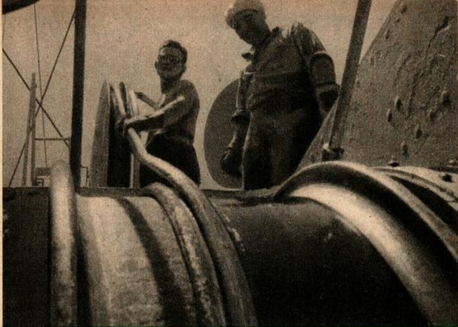
Le délicat travail consistant à relever le câble et à l'immerger sans changer la tension est aidé par ce tambour de tension. Utilisant des « disques de déponillage » pour maintenir tous les fils séparés et en bon ordre, toute l'équipe se met au dénudage d'une nouvelle section.
