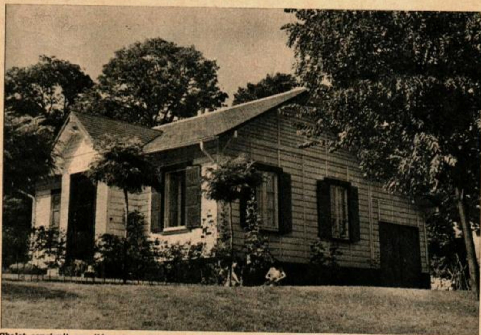
Chalet construit par éléments préfabriqués en bois, posés sur soubassement en maçonnerie. Livré et monté en quelques semaines, il constitue une habitation agréable et d'un prix de revient peu élevé. Peinture, tapisserie et décoration peuvent être exécutés immédiatement après le montage sans risque d'humidité. De nombreux modèles existent dans ce genre de construction.
