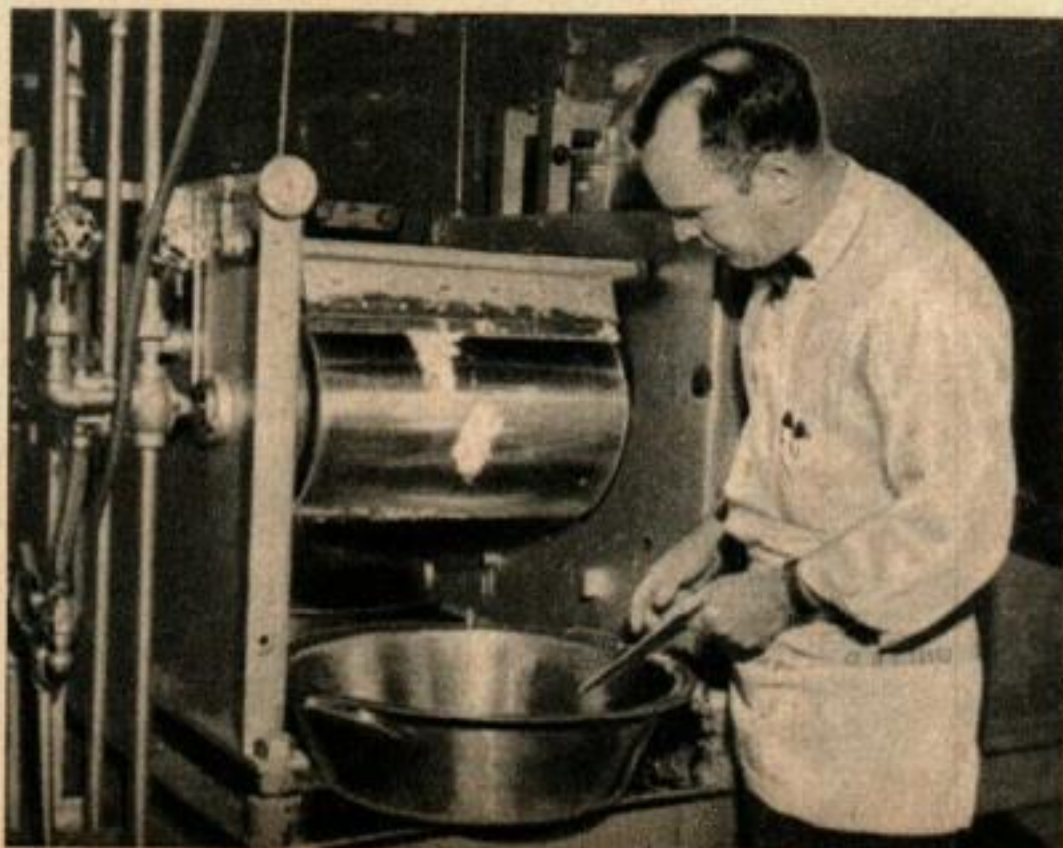
Ce séchoir à tambour est utilisé par un des savants du ministère de l'Agriculture des U.S.A. dans une étude dont le but est de mettre au point une purée de pommes de terre déshydratée améliorée... encore un autre plat « instantané ».
