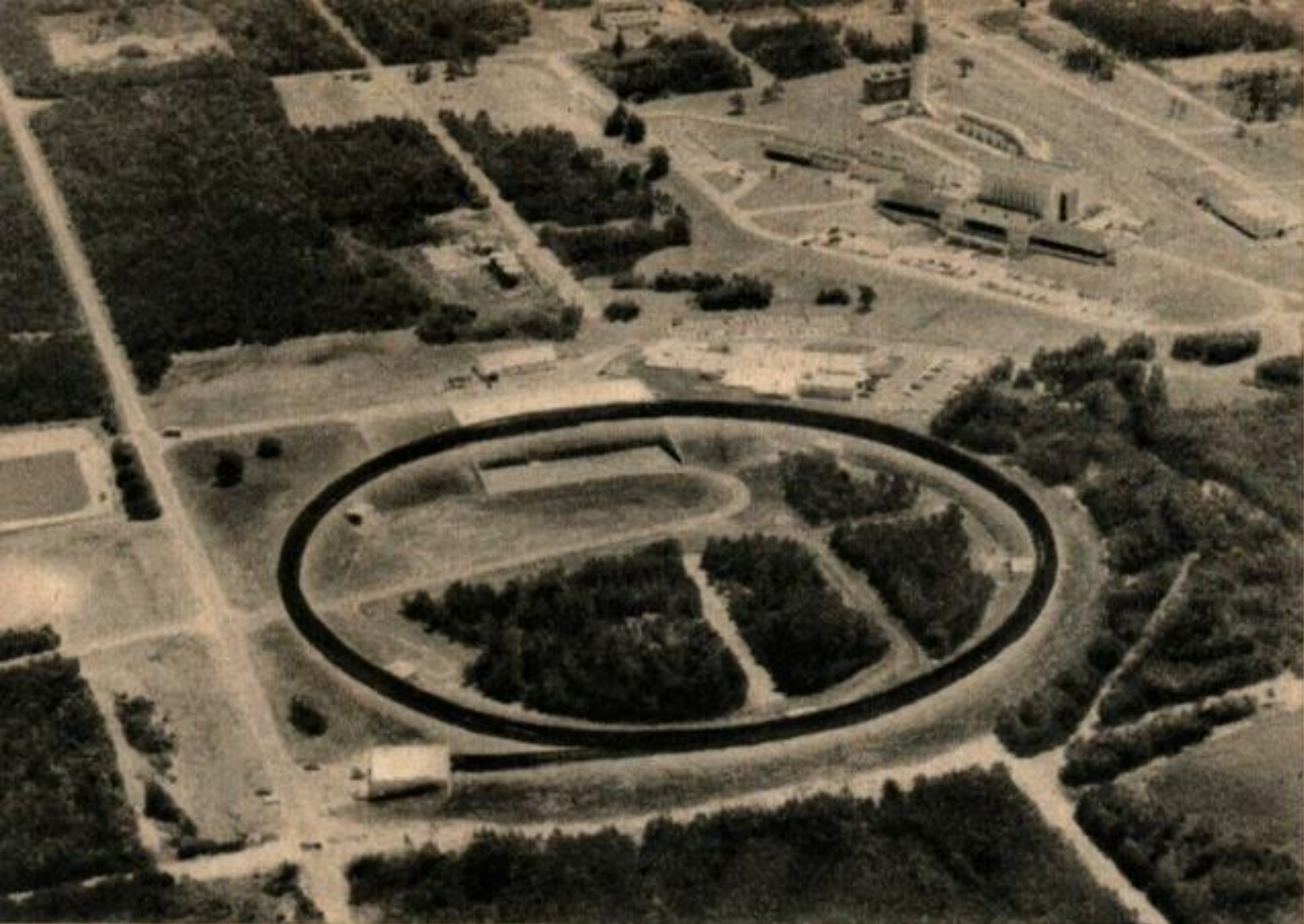
Enterré sous 3 m de terre et de béton, le tunnel dans lequel est logé le canon atomique s'incurve comme une piste de course de 800 m.
