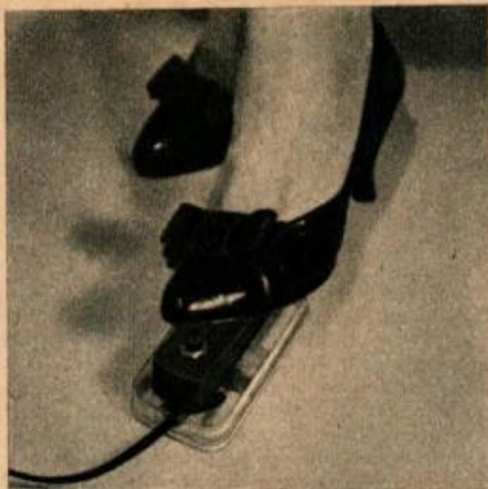
L'interrupteur à pied, monté sur un coussinet, fait démarrer l'enregistreur à bande et l'arrête de sorte que la dactylo peut se rattraper.
