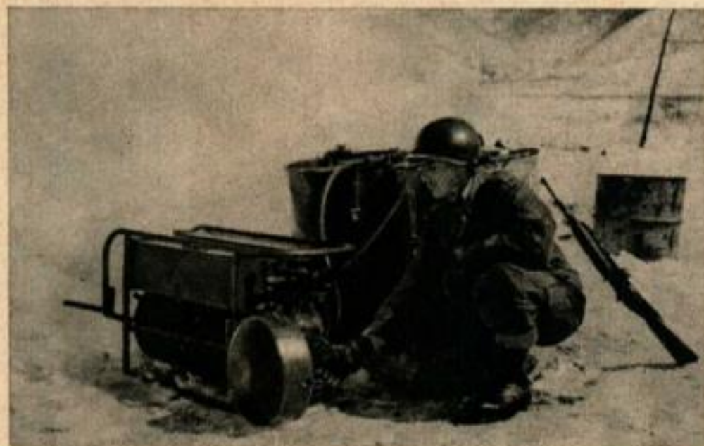
La version de la Marine Américaine de cette génératrice de brouillard à réacteur à pulsation des Services Chimiques de l'Armée de Terre peut creuser des trous de poteaux, dégeler les rues et protéger les vergers.
