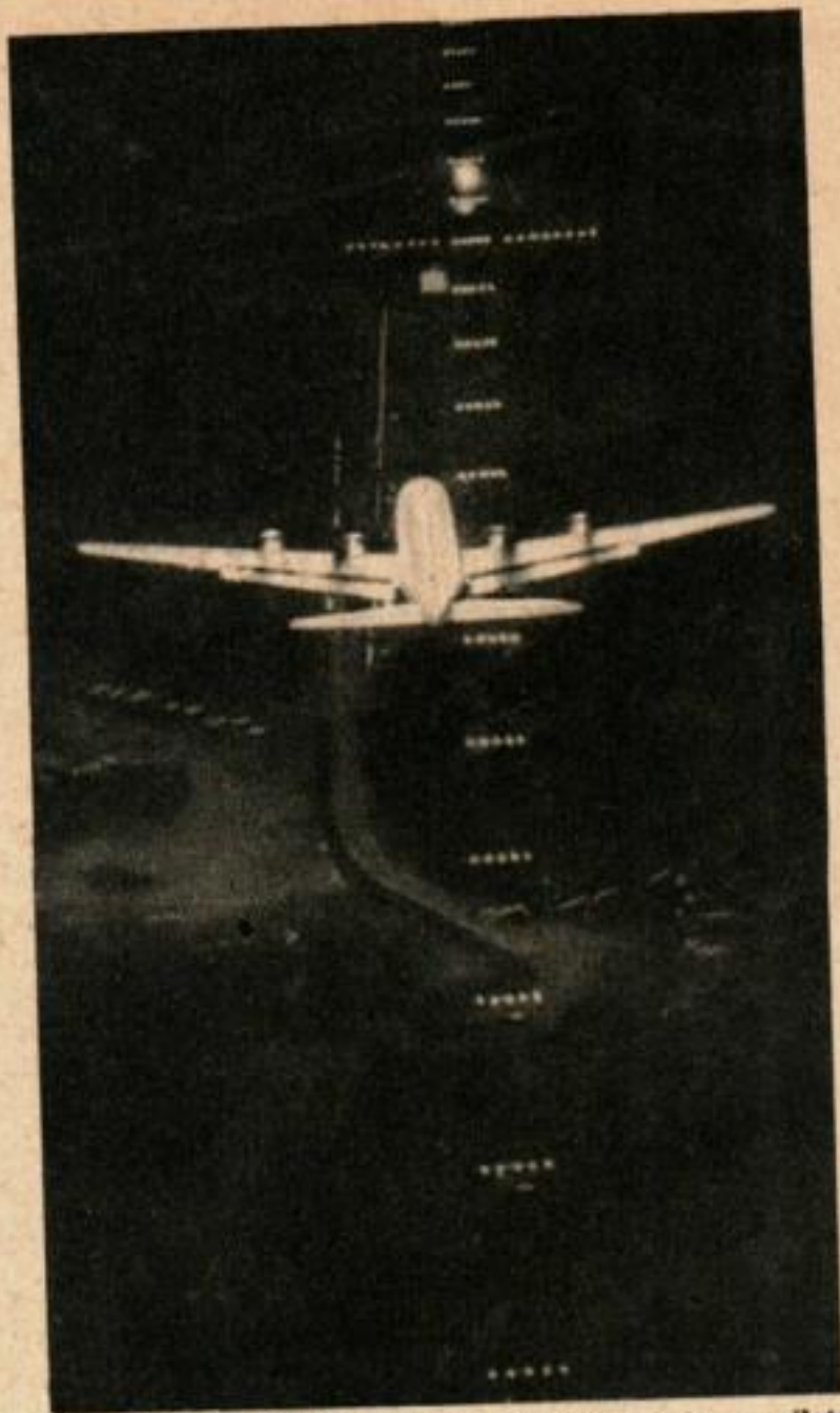
Le système à ligne lumineuse centrale, tel que celui-ci, qui est installé sur un autre aéroport, montre au pilote le chemin de la piste pour les atterrissages nocturnes.
