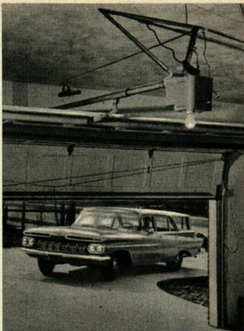
Dispositif d'ouverture de porte de garage commandé par radio et contenu dans un sachet de cuir, facilement transportable. La pression du bouton fait ouvrir la porte.
