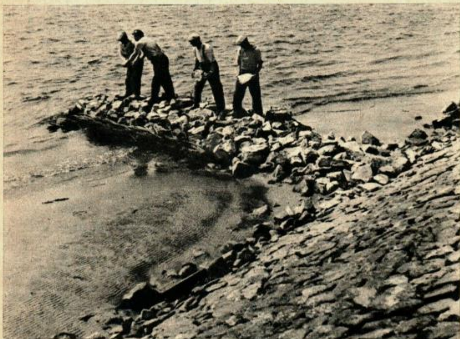
La marée descendante révèle l'étendue des dommages causés par la mer et les gardiens commencent à réparer la digue, l'une d'un grand nombre qui empêchent l'eau d'inonder leur terre arable gagnée sur la mer. Ils construisent tout d'abord un bâtardeau en blocs de basalte disposé à angle droit par rapport à la digue, afin qu'à marée haute la mer soit calme auprès de la zone de travail.
