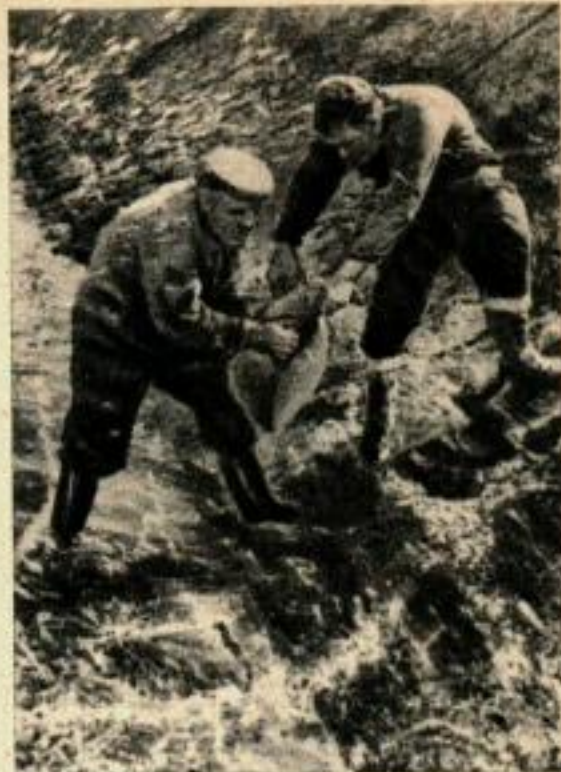
L'eau clapote autour de la digue, tandis que Jan ferme les portails qui barrent la route du port, laquelle passe sur le dessus de la digue. La mer ayant déjà affaibli les murs de la digue, Jan et son fils tassent des sacs de sable dans la brèche, à droite. Les gardiens des digues emploient le téléphone et des camions pour agir rapidement sur tout le réseau d'entretien.
