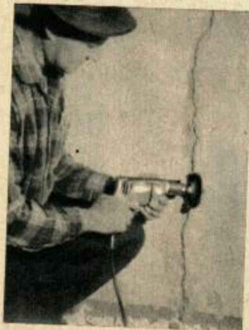
6. Cette composition à prise rapide en deux éléments est idéale pour le bouchage des fissures soumises à l'humidité, comme dans un sous-sol.
