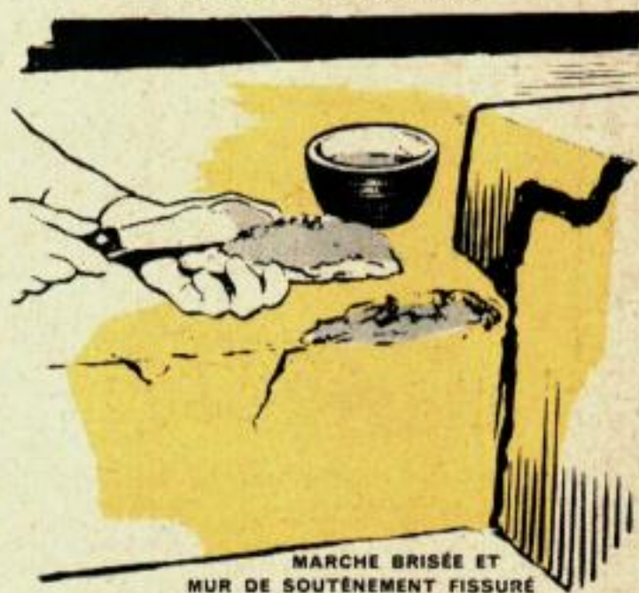
8. Lorsque des morceaux de béton sont cassés en des endroits supportant une importante circulation, comme sur des escaliers, la meilleure façon de les réparer est avec du mastic époxique.
