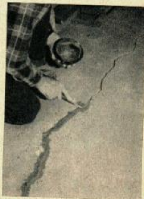
6. Cette composition à prise rapide en deux éléments est idéale pour le bouchage des fissures soumises à l'humidité, comme dans un sous-sol.
