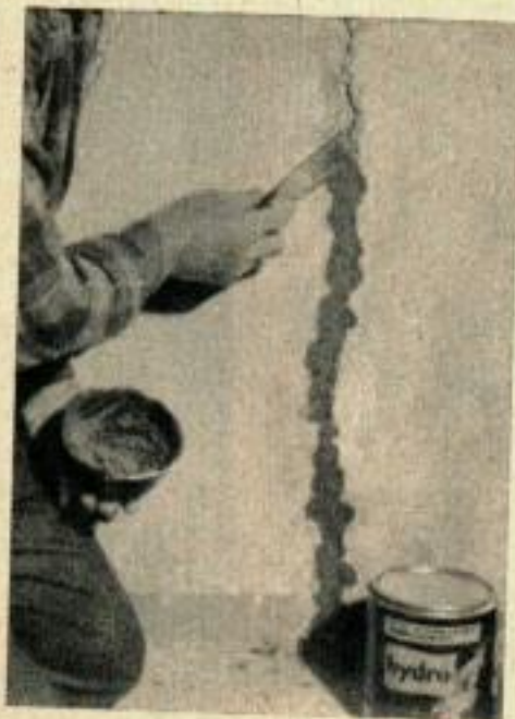
6. Cette composition à prise rapide en deux éléments est idéale pour le bouchage des fissures soumises à l'humidité, comme dans un sous-sol.
