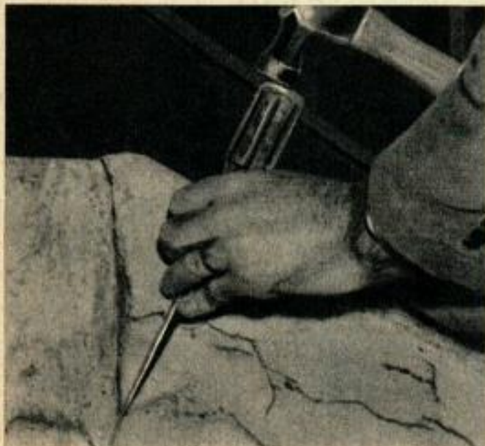
9. Les fissures étroites du béton sont légèrement élargies afin de donner à la composition de réparation une meilleure chance de s'ancrer solidement.
