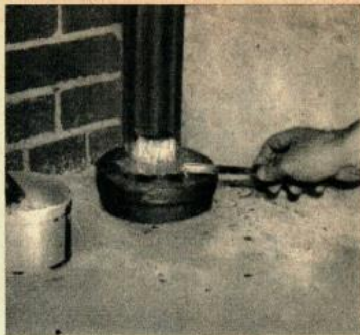
7. Ce tuyau de descente décollé de son logement est calfaté avec du mastic époxique, après avoir été enveloppé dans une mince feuille plastique qui permettra de le retirer librement lorsqu'il sera nécessaire de le remplacer.
