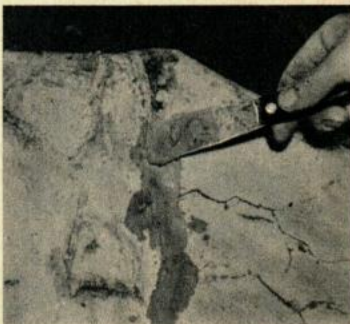
9. Les fissures étroites du béton sont légèrement élargies afin de donner à la composition de réparation une meilleure chance de s'ancrer solidement.
