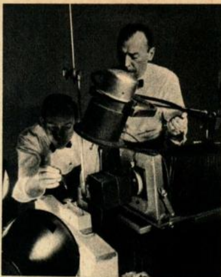
Les gouttes pressées d'un compte-gouttes tombent sur une plaquette de verre pour actionner les lampes stroboscopiques. L'objectif de l'appareil photographique est ouvert.
