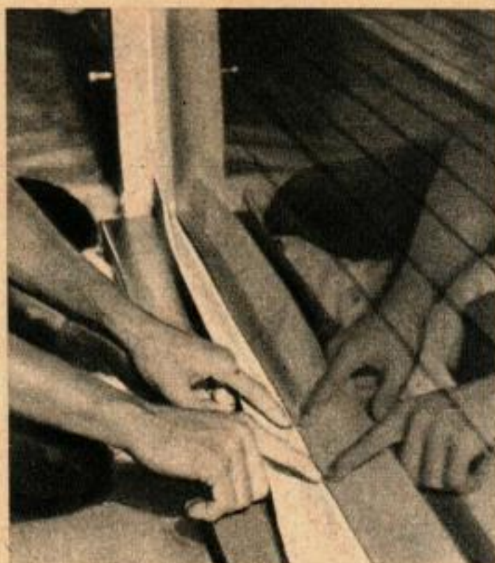
1. Lorsque l'émulsion coule en descendant le long de la vitre, un certain excès de liquide est inévitable. Pour arrêter celui-ci, utiliser une gouttière en gros papier de boucherie résistant à l'humidité.
