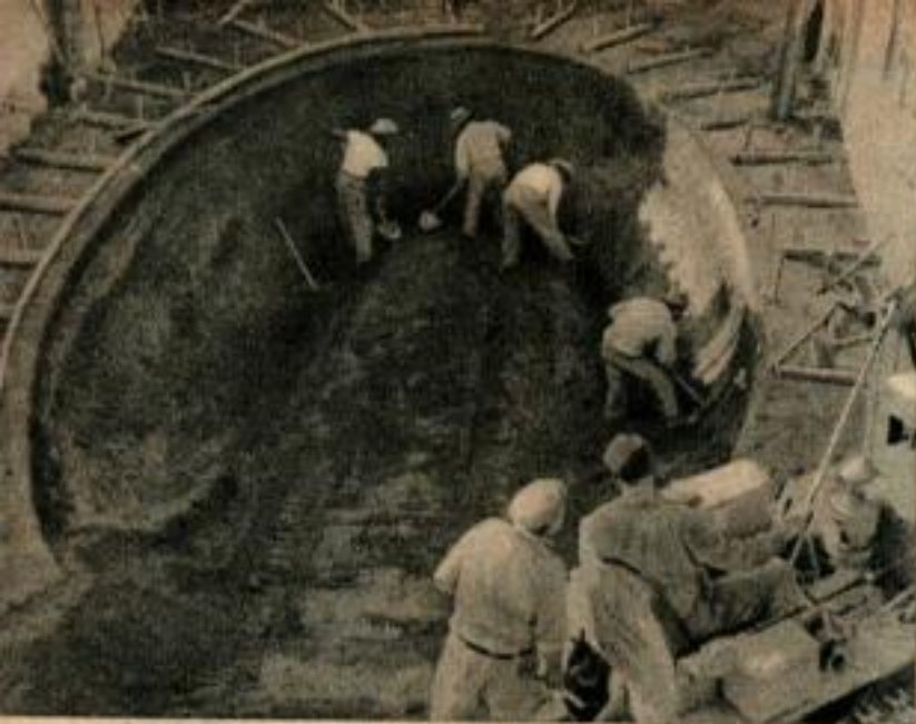
Lorsque l'excavation a été creusée, le travail peut passer rapidement par les diverses phases aboutissant aux touches de finition. Remarquer le coffrage du couronnement.
