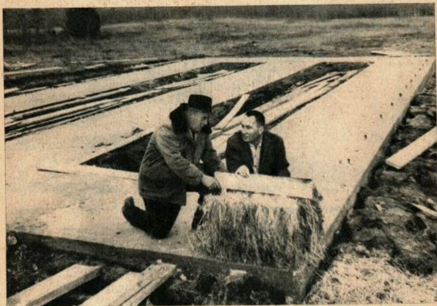
Des bottes de paille pressée — abondante aux environs de Sexsmith, qui prétend au titre de capitale du grain de l'Empire britannique — furent placées sur un soubassement en béton pour former les murs. Ci-dessous, avec le clocher en place et les murs crépis, la chapelle est presque terminée.
