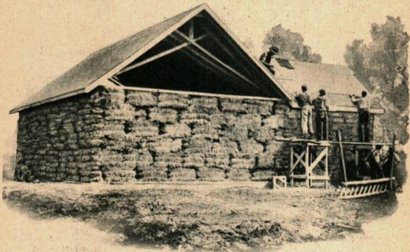
Perché sur le toit du bâtiment, le Père Francis Dale surveille la pose des ardoises en bois pendant la construction de la chapelle de paille de Sexsmith, Alberta, Canada. Les murs de paille n'ont pas été crépis.
