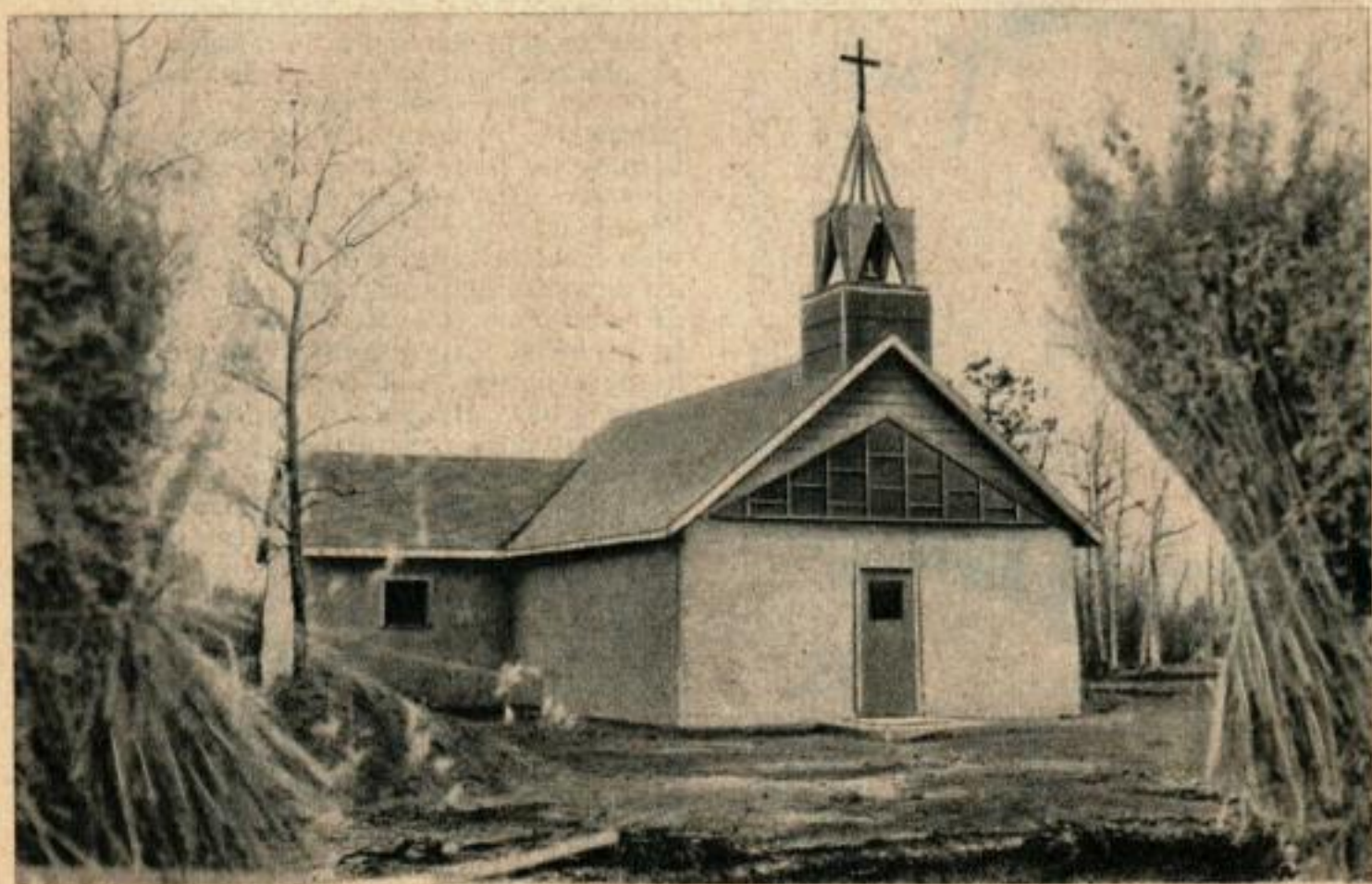
Des bottes de paille pressée — abondante aux environs de Sexsmith, qui prétend au titre de capitale du grain de l'Empire britannique — furent placées sur un soubassement en béton pour former les murs. Ci-dessous, avec le clocher en place et les murs crépis, la chapelle est presque terminée.
