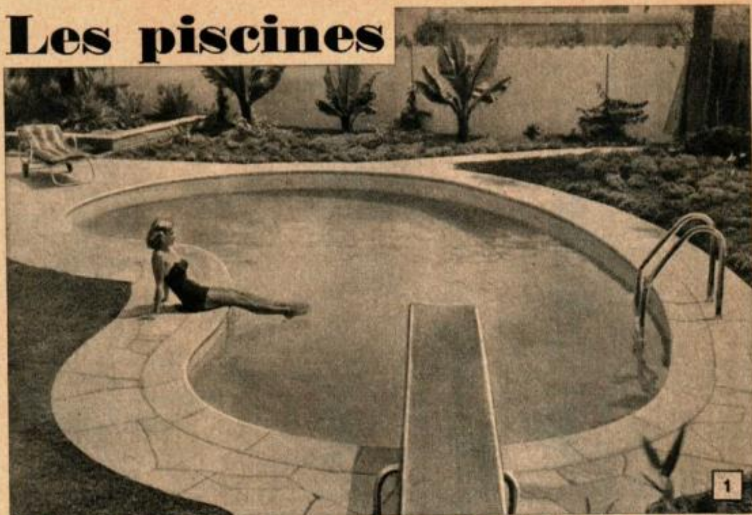
Cette luxueuse piscine de forme libre mesure environ 4,90 m \times 10,35 m. Elle est construite en béton appliqué sous pression et coûte environ 17 000 NF.
