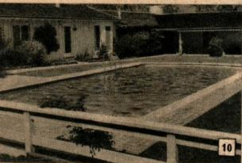
Etant très bien enclose, cette piscine de 6 x 12 m est d'un entretien très facile. Elle est caractérisée par un couronnement de bordure pré-coulé et par des trottoirs d'entourage antidérapants en briques.
