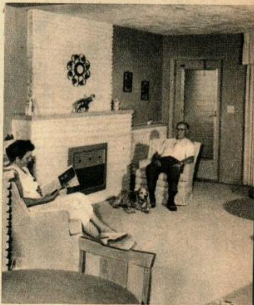
Le système de chauffage électrique d'habitation le plus coûteux est la pompe thermique, montrée ici installée dans la cheminée d'une maison de Floride. Elle rafraîchit en été et réchauffe en hiver. L'installation fonctionne à peu près comme un réfrigérateur ou un conditionneur d'air. En hiver cependant, l'air froid est pompé hors de la maison et la chaleur est distribuée dans celle-ci.
