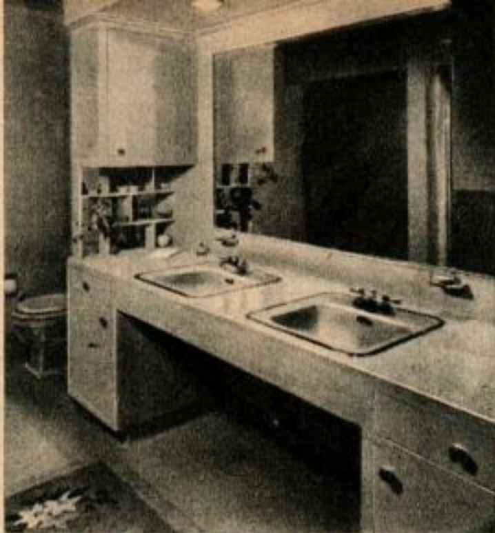
La maison qui vous en donne le plus pour votre argent comprend une salle de bains complète avec un bon éclairage et un chauffage électrique.
