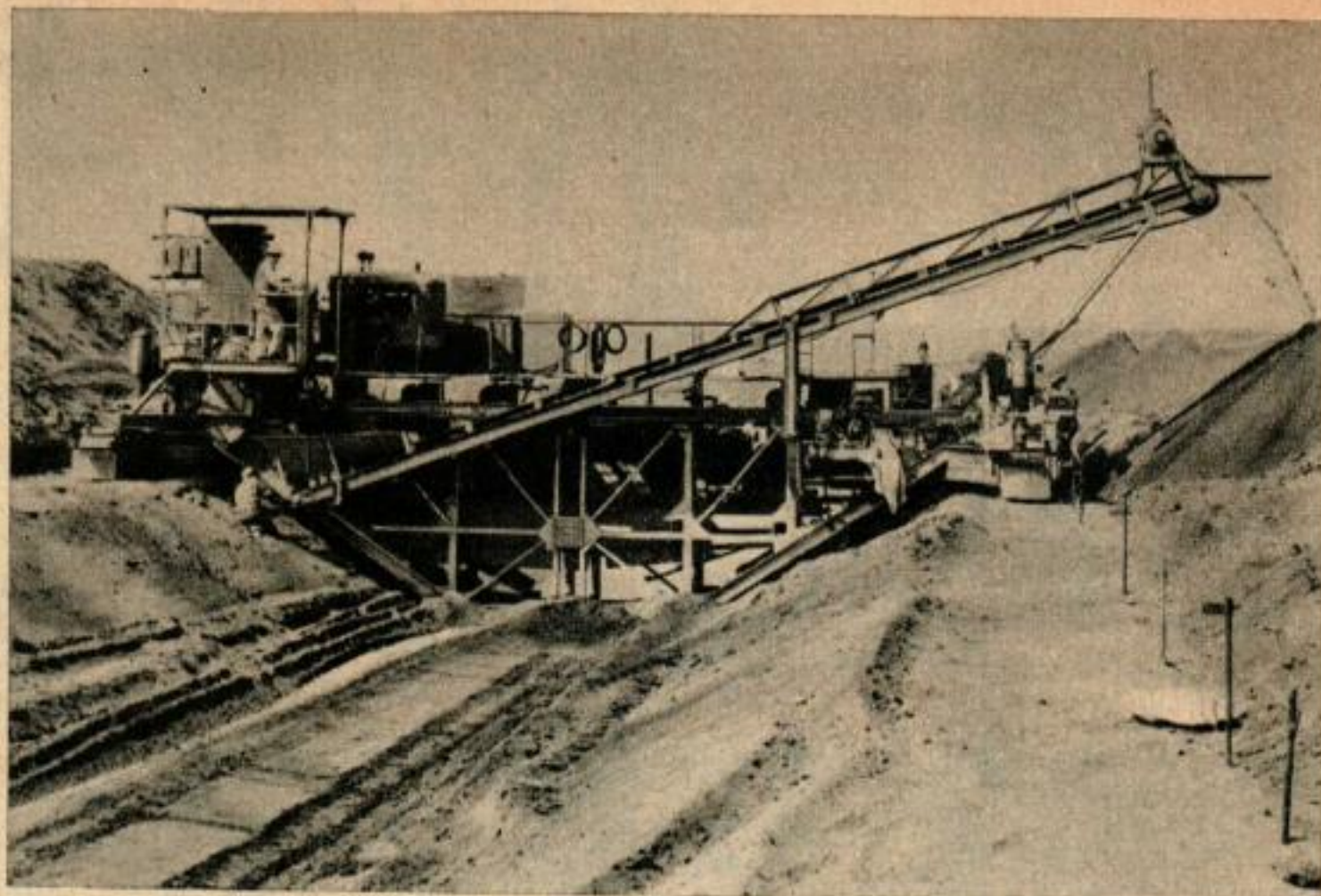
Cette vue de devant de la machine à construire les canaux montre comment elle prélève la terre sur le lit dégrossi et la déverse, à droite. Les piquets que l'on voit au premier plan à droite supportent une ligne en fil métallique qui aide à mettre la machine en place sans supervision de l'opérateur.
