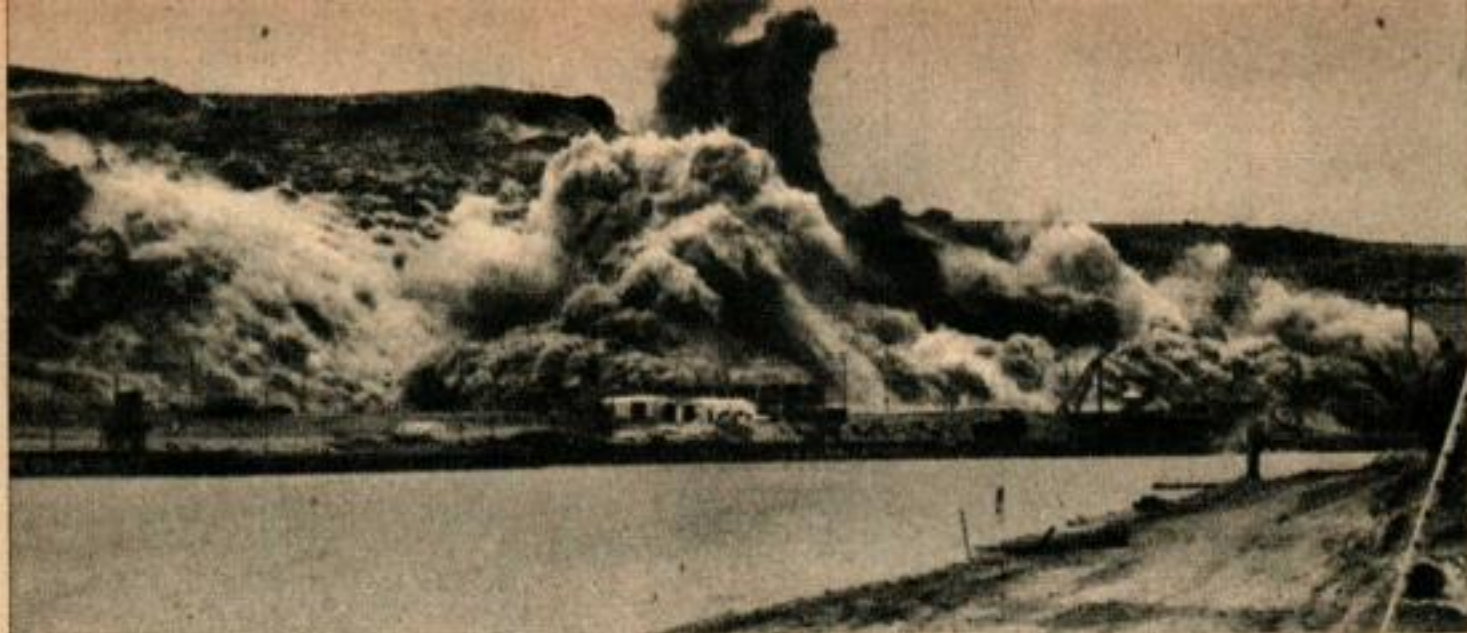
Un flanc de montagne de l'Utah tout entier se transforme en une seconde en remblai rocheux au moment où le coup de mine de la pointe du Promontoire est tiré par l'intermédiaire d'un réseau de cordons détonnants et de dispositifs d'amorçage extrêmement compliqué. La quantité de fumée et de débris volants relativement réduite atteste de l'habileté de la mise en place des explosifs, car le bruit et les projections de débris signifient qu'une partie de la force explosive est gaspillée à déplacer de l'air. Cette explosion fut la dernière d'une série supervisée par les conseillers techniques de la compagnie Atlas, et jusqu'à Ripple Rock, la plus forte explosion non atomique déclenchée intentionnellement.
