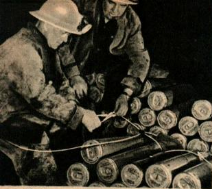
Dans les profondeurs intérieures de Ripple Rock, les ingénieurs de la compagnie Du Pont pincent le cordeau détonnant sur les boîtes métalliques d'agent explosif Nitramex. Le cordeau détonne à la stupéfiante vitesse de 6 000 m à la seconde, permettant de faire exploser instantanément des charges largement séparées.
