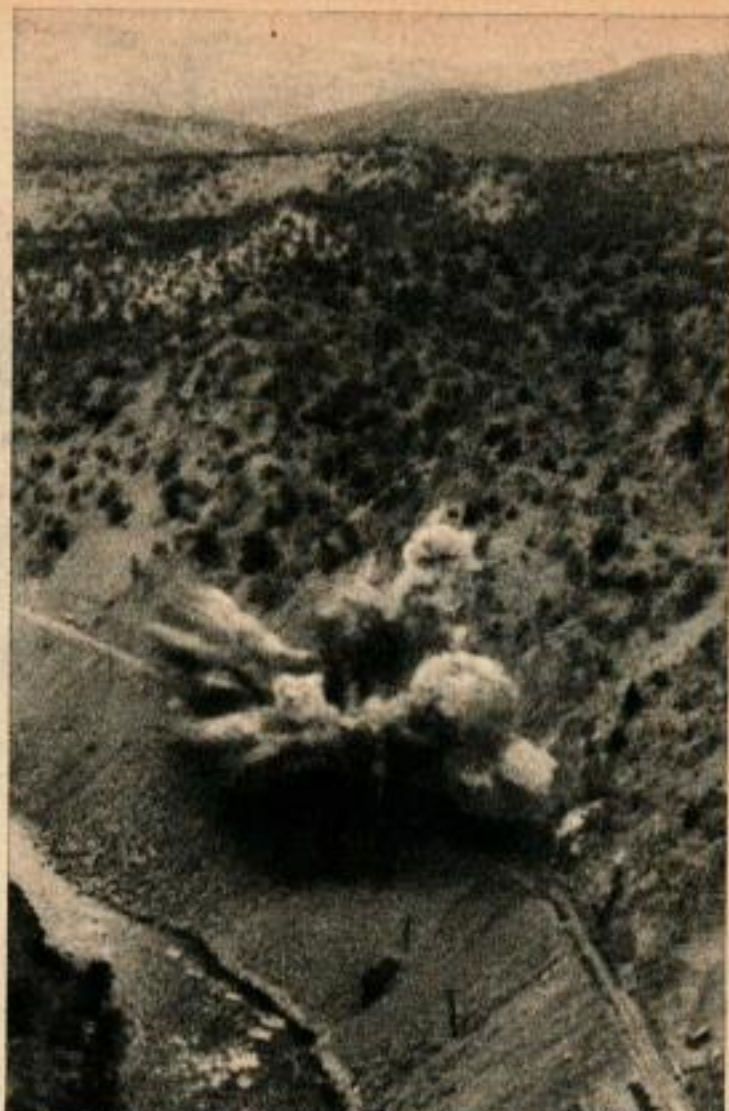
Immédiatement après le passage du train, les experts de la compagnie Atlas tirèrent un énorme et unique coup de mine calculé pour faire sauter tout l'affleurement granitique dans le canyon. 25 000 t de roc devaient être déplacées sans endommager l'importante voie ferrée au-delà de réparations temporaires immédiates.
