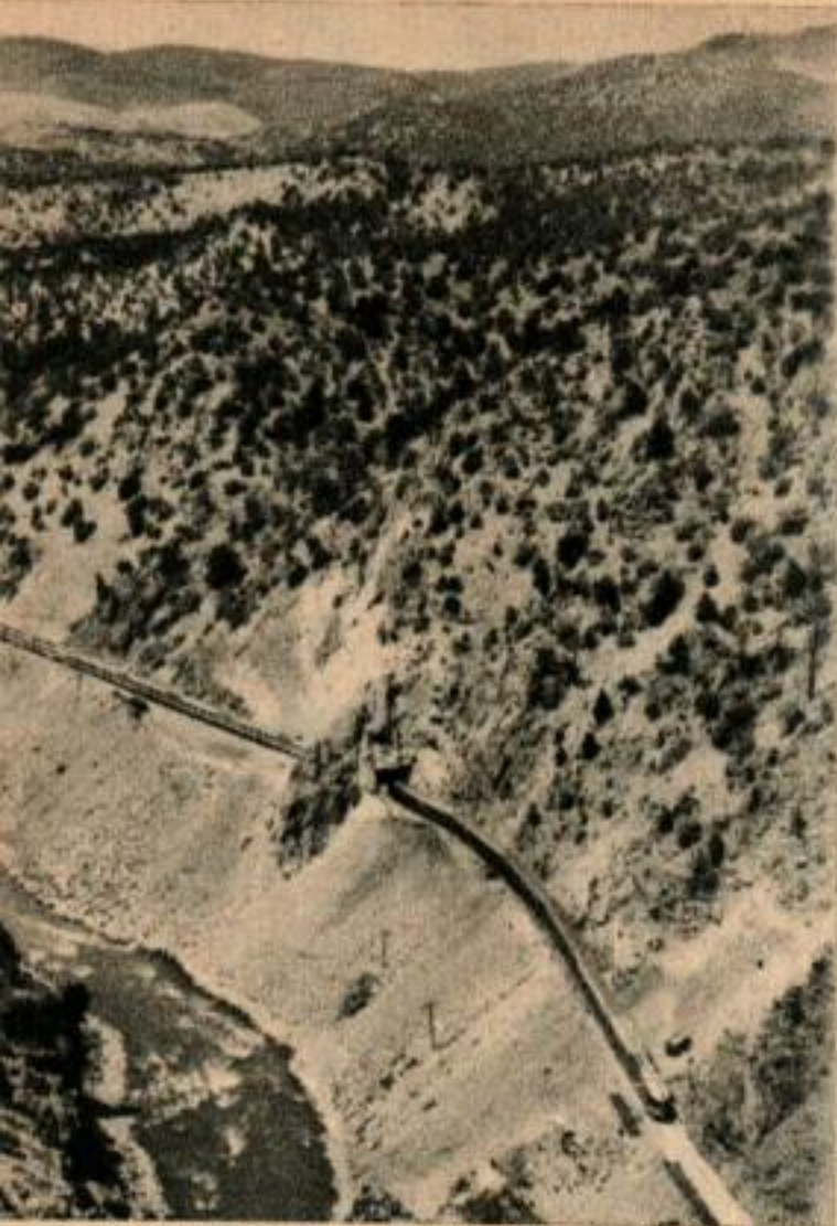
Le dernier train de voyageurs à destination de l'Est passe à travers un tunnel de 30 m sur le chemin de fer de Denver et Rio Grande, dans le Gore Canyon du fleuve Colorado. Les plans de démolition du tunnel devaient permettre de le supprimer sans interrompre les services ferroviaires sur la ligne.
