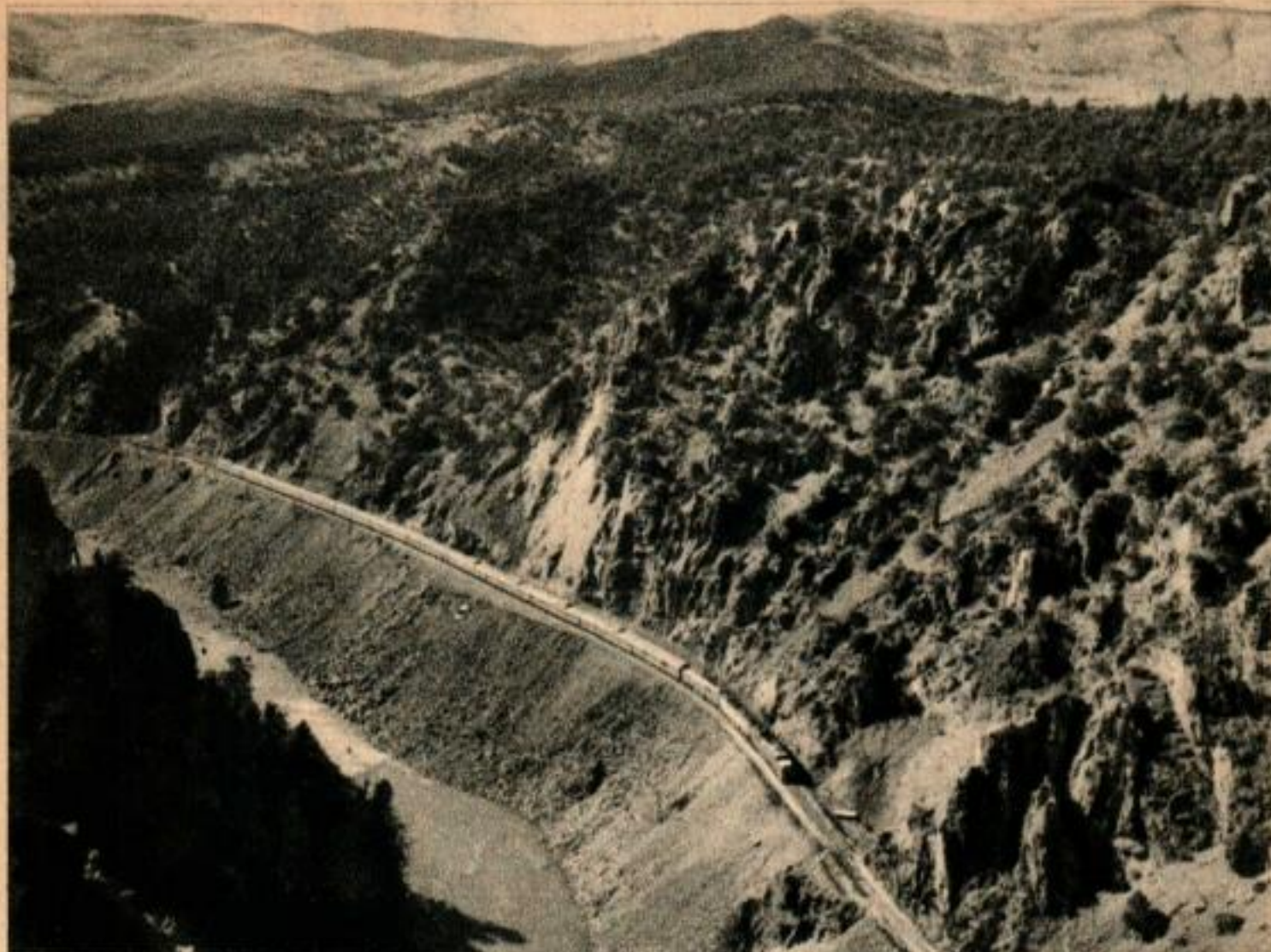
Dès que les débris eurent fini de rouler, deux grosses pelleteuses et plusieurs douzaines d'hommes se mirent au travail pour rejeter des tonnes de granit pulvérisé sur le flanc du canyon, suivis au fur et à mesure de l'avancement du travail par des équipes de poseurs installant la voie provisoire. Dans l'heure qui suivit, le train « California Zephyr, » ci-dessus, passa en toute sécurité sur le lieu où seule une cicatrice fraîche marquait l'emplacement de l'affleurement rocheux sous lequel se trouvait précédemment le vieux tunnel de Gore Canyon.
