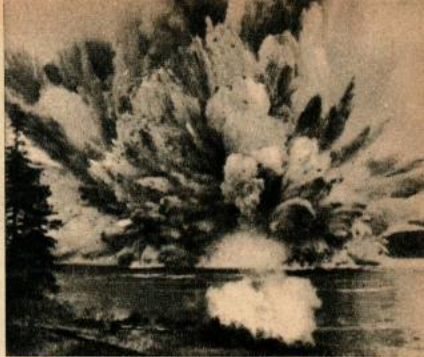
Zéro plus 4,7 secondes. De gros blocs de rochers apparaissent dans le geyser d'eau et de fumée de 300 m au moment où Ripple Rock est projeté dans les airs. La photo de la page 17 montre l'explosion à son maximum, 8,4 secondes après la mise de feu des charges.
