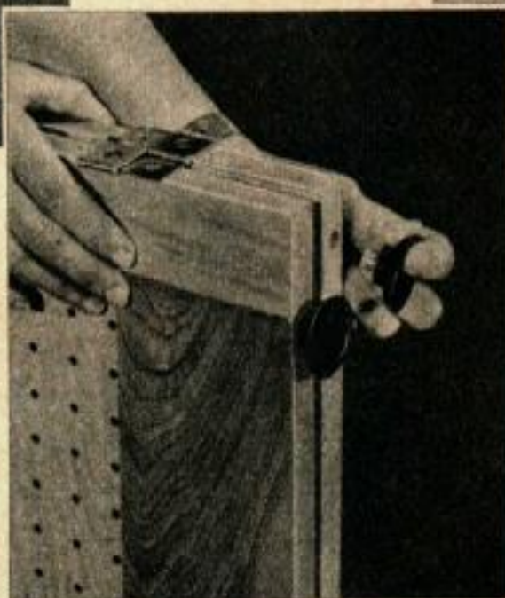
5. Les ventouses en caoutchouc servent de pieds et maintiennent le paravent en place pendant la fixation de papiers ou gravures sur le « tableau d'affichage ». Elles sont disposées en quinconce afin de se dégager mutuellement lorsque le paravent est replié à plat.
