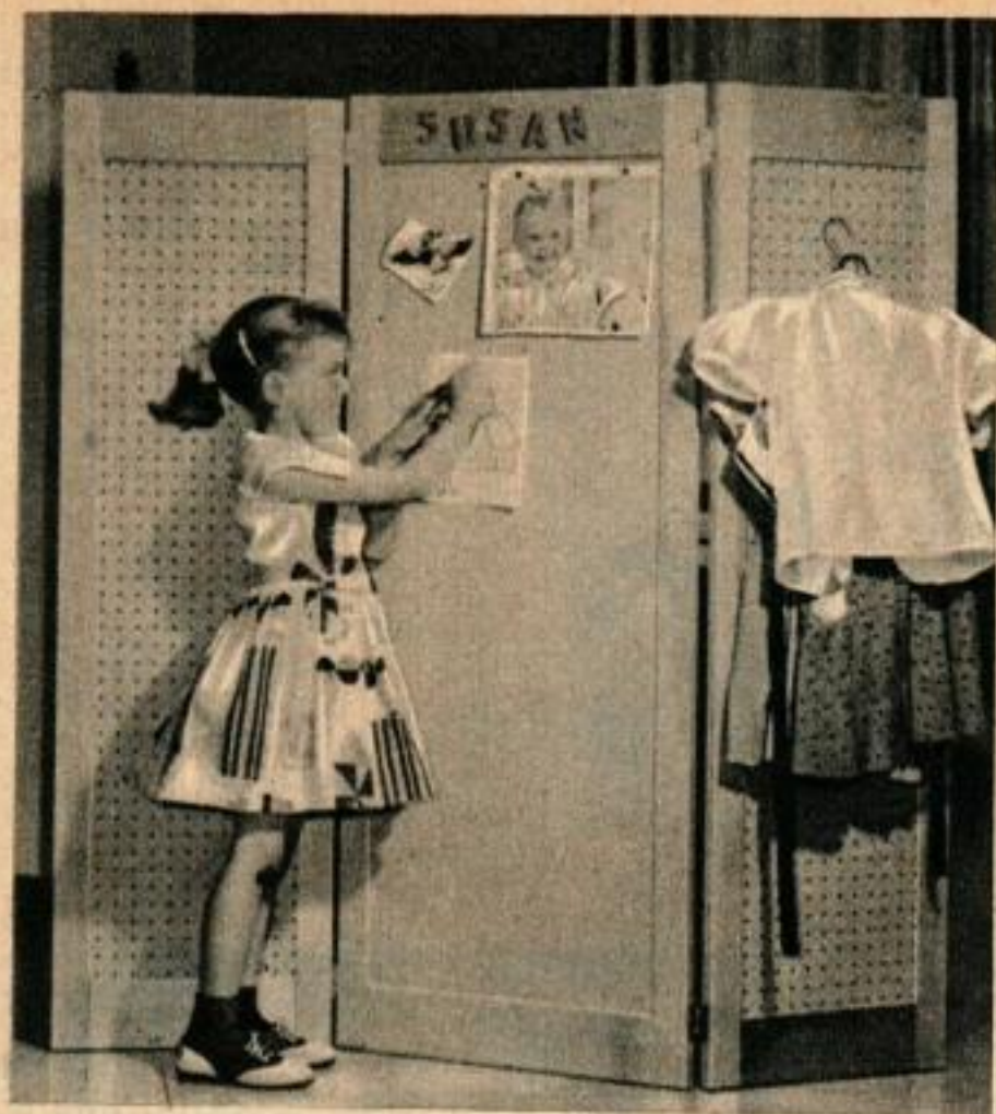
2. Le paravent pliant à usages multiples présente deux panneaux en fibre perforée permettant de suspendre des vêtements en cours de changement et un panneau central en plaque isolante servant de tableau d'affichage.
