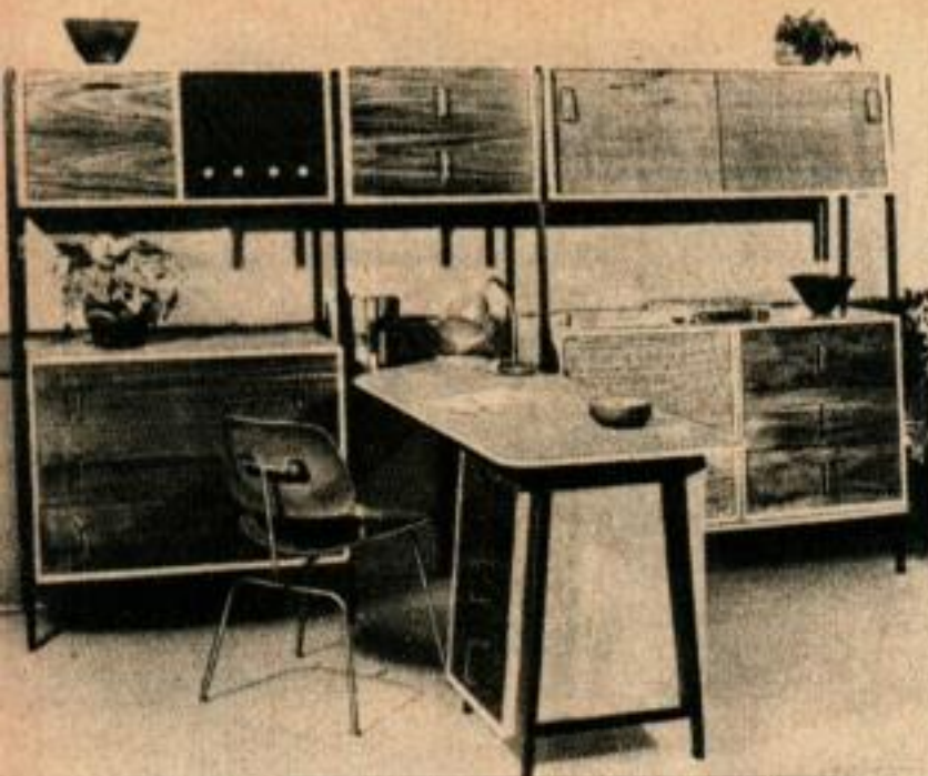
Ce bureau et ces placards en bois montés dans une charpente en profilés d'acier en U ont été confectionnés uniquement avec une clé anglaise et une scie à métaux, plus les outils de travail du bois.
