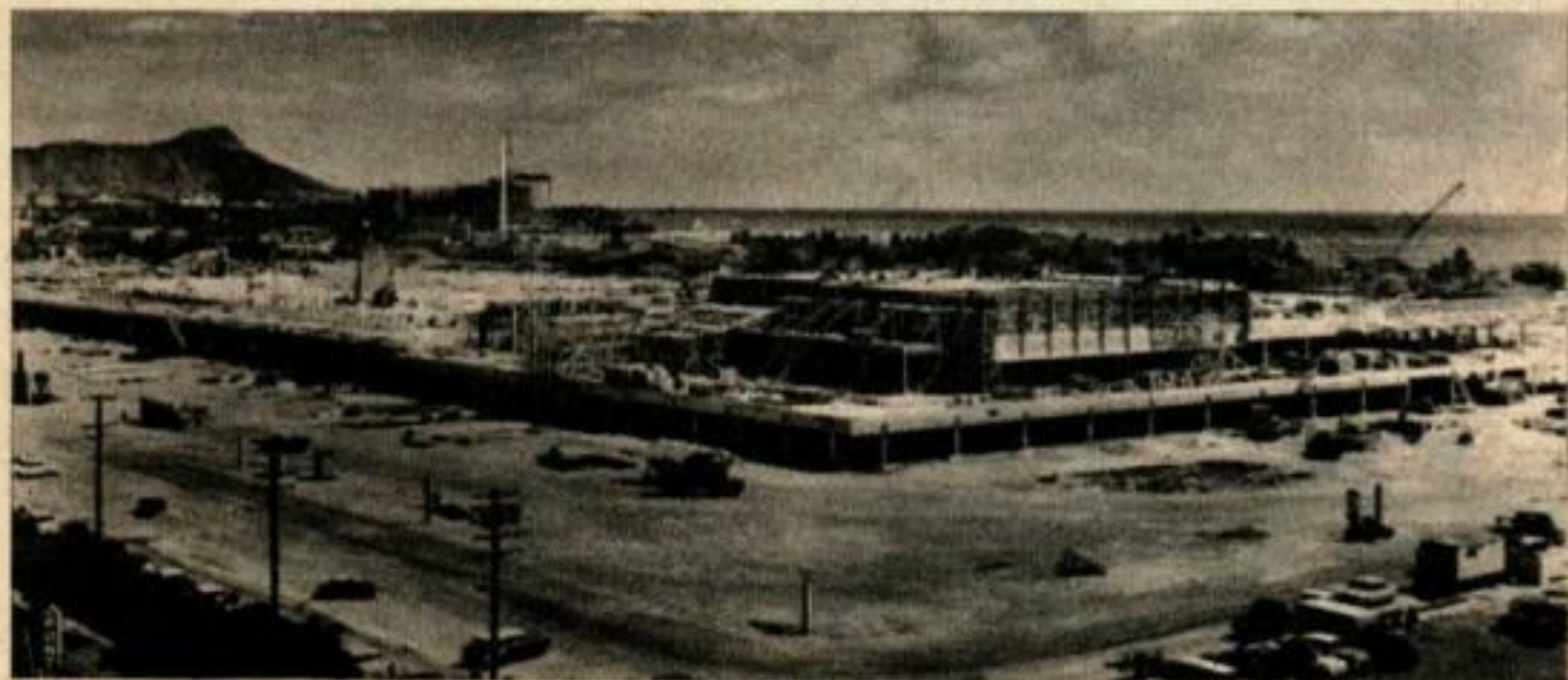
La construction est en plein essor sur tout Hawaï, et particulièrement autour d'Honolulu et de Waikiki. Le Centre Commercial d'Ala Moana, montré ci-dessous, coûtera 8 milliards de francs et sera l'un des plus grands du monde. Ce sera presque une cité indépendante.
