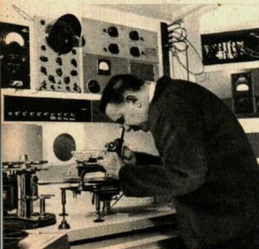
Scott emploie un microscope pour vérifier si les sillons sont coupés correctement dans un disque d'essai enregistré dans son propre studio.
