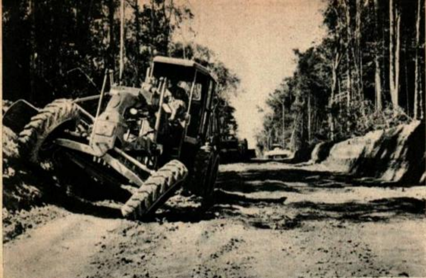
Alors que de nombreux outils de construction primitifs sont encore utilisés à la construction de la route, le matériel moderne tel que les bulldozers et les niveleuses sert aussi à recouper les bas-côtés de la route pour l'élargir en la préparant au revêtement.
