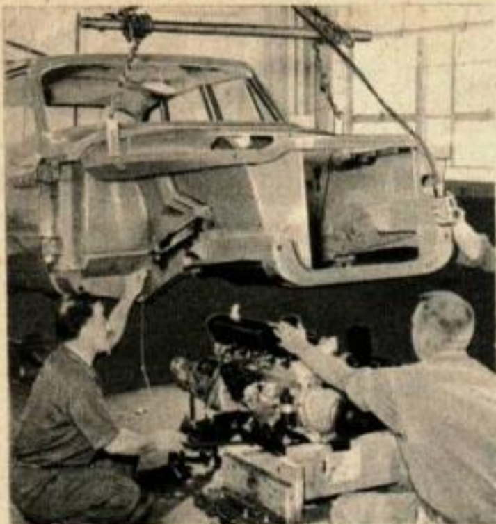
La carrosserie monocoque de la Valiant ne comporte pas de châssis, sa force structurale provenant de la tôle elle-même. Les garde-boue avant sont rapportés et boulonnés.
