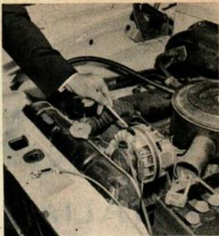
Au lieu d'une dynamo, ou génératrice, la Valiant est équipée d'un alternateur. Plus petit, plus léger et plus simple, celui-ci charge la batterie même lorsque le moteur tourne au ralenti.
