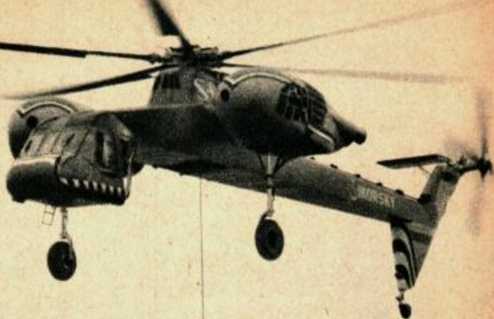
Le « crochet céleste » S-60 modèle 1959 de Sikorsky est une « grue volante » sans cale de chargement. Il peut transporter une charge de 6 t.
