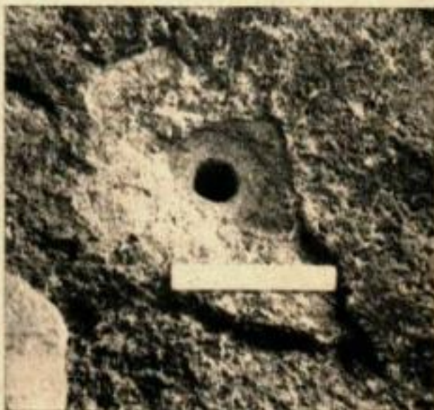
Cette vue de face d'un trou juste après l'explosion montre sa dimension par rapport à une règlette de 15 cm.
