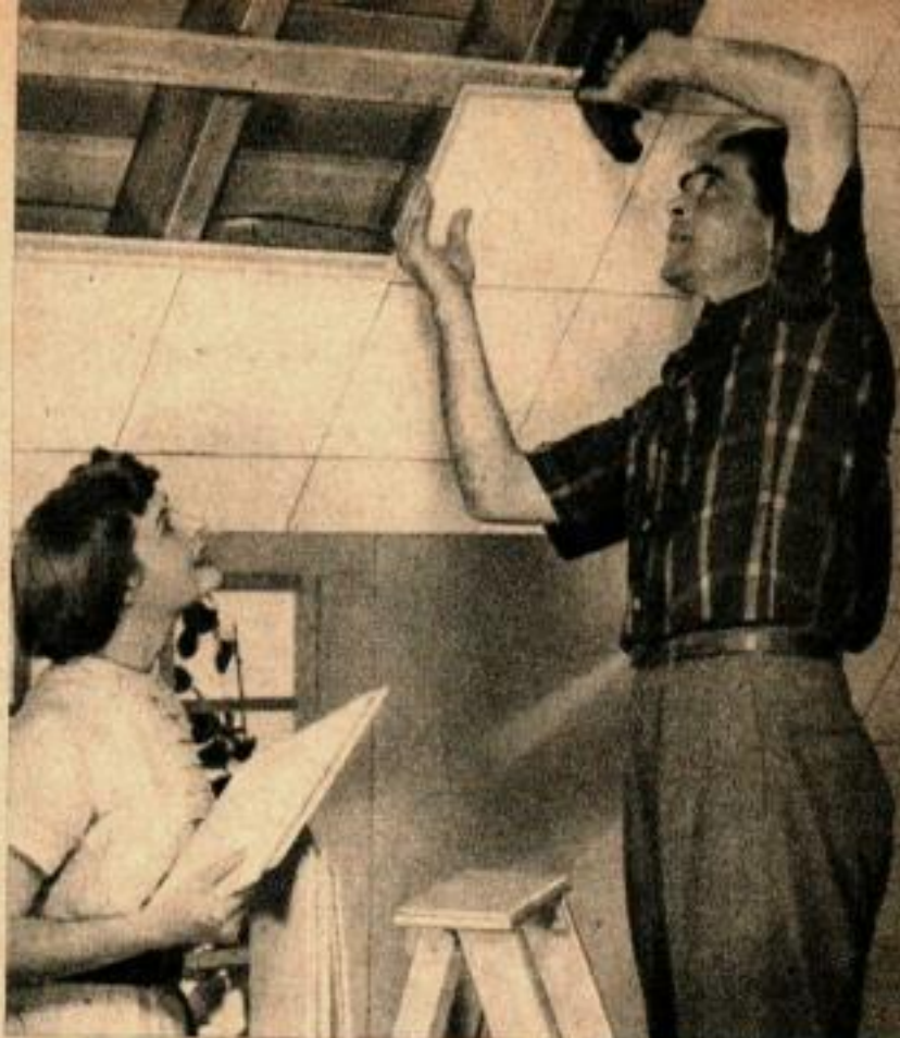
1. La fixation rapide des carrelages de plafond par leurs rebords dissimulés n'est qu'un seul des nombreux travaux pour lesquels il est idéal d'utiliser un pistolet agrafeur.
