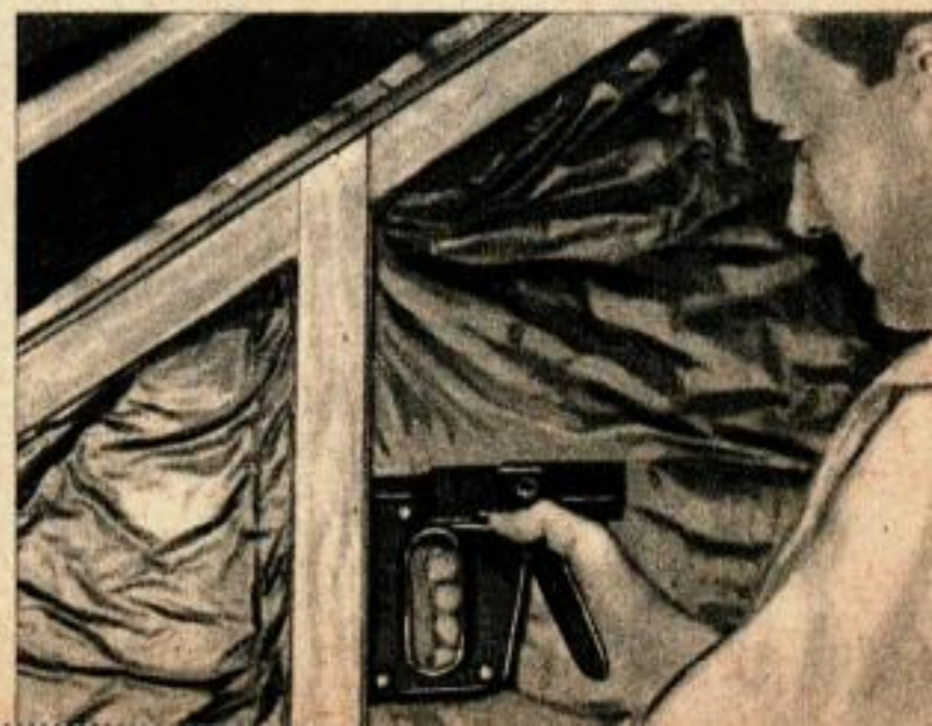
8. Ci-dessus: La réfection de la tapisserie des sièges de chaises avec du tissu ou de la matière plastique est un autre travail d'agrafage assez facile. 9. Ci-dessous: La mise en place de matériau isolant est probablement le travail que l'on considère le plus couramment comme à effectuer de préférence avec une agrafeuse.
