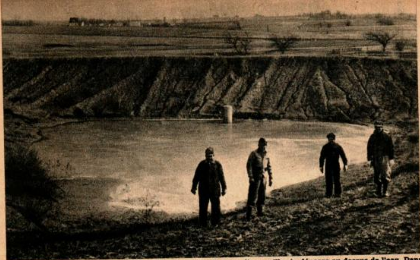
Voici un bassin de retenue nouvellement construit dont la prise d'eau grillagée dépasse au dessus de l'eau. Dans le cas de cette photo, les talus ou berges de l'étang n'ont pas encore été ensemencés avec les herbes protectrices qui préviendront l'érosion et empêcheront la pièce d'eau de s'envaser ou de devenir boueuse.
