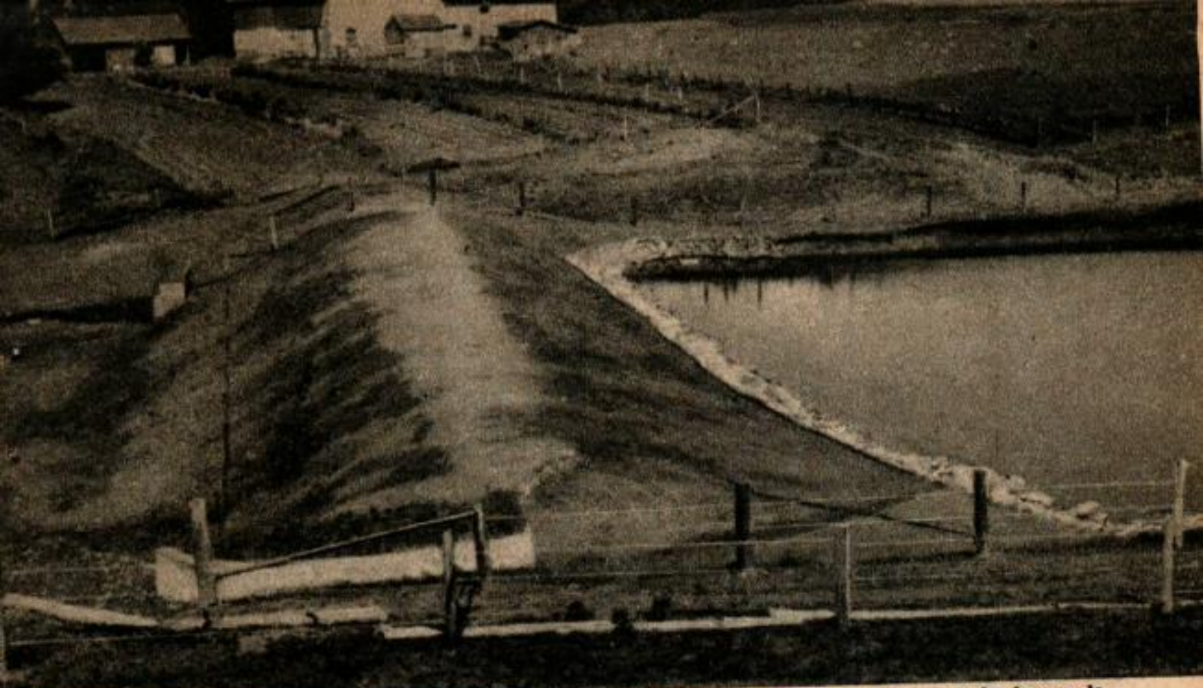
Ce barrage et cet étang types sont clôturés pour empêcher le bétail d'endommager la digue ou les berges de l'étang et de provoquer la formation de boue sur ces dernières. Notez que le déversoir de secours gazonné est également clôturé pour éviter qu'il soit endommagé.
