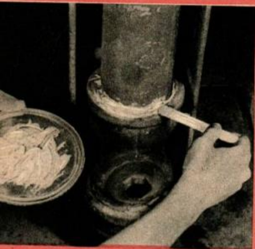
Réparation d'une conduite qui fuit avec une mixture à parties égales d'éléments de résine époxyde livrés en deux tubes.
