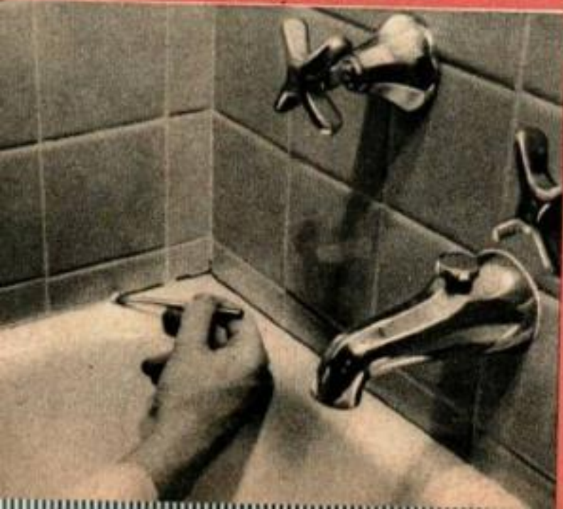
Le Hysol, une autre marque de résine époxyde, est utilisé ici par le propriétaire de la maison pour calfeutrer le bord de sa baignoire, lequel est fréquemment l'objet d'infiltrations.
