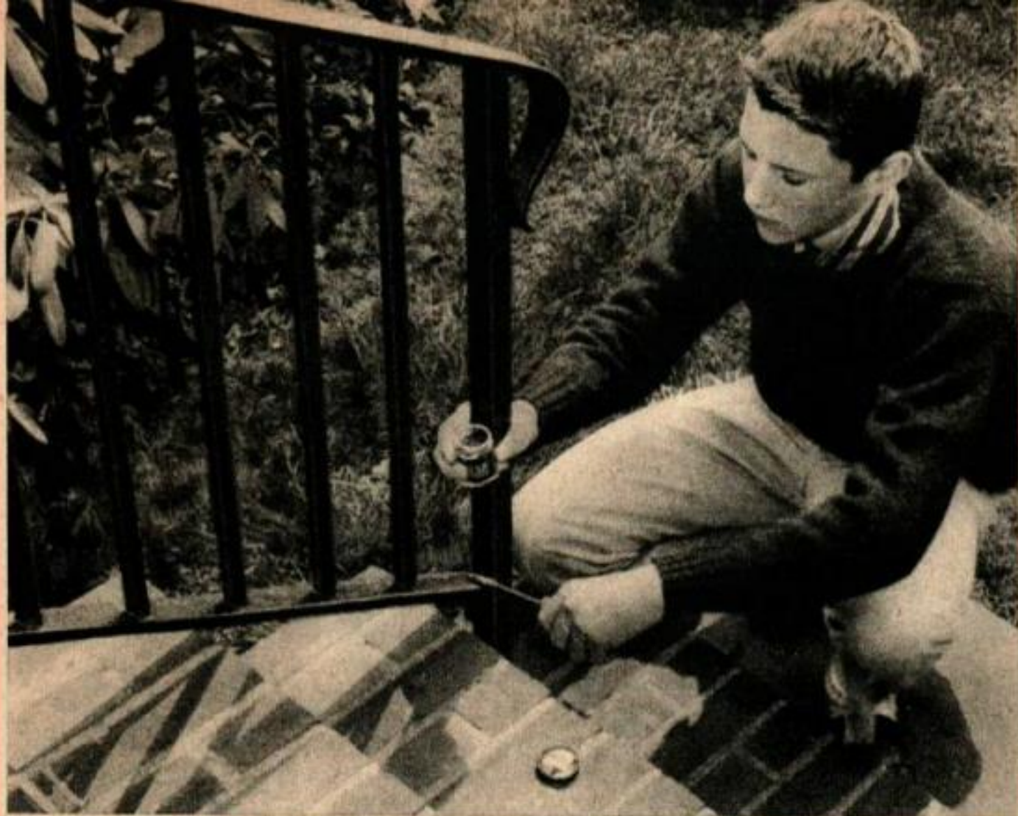
La solide prise de ces nouvelles colles les rend extrêmement pratiques pour la réparation, et même pour l'installation des balustrades en fer forgé.
