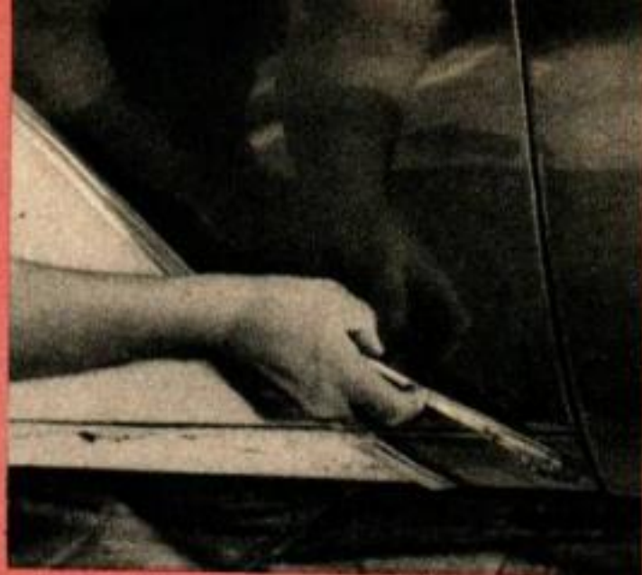
La résine époxyde est ensuite mélangée avec le catalyseur, ce qui forme une substance semblable à du mastic, laquelle s'applique sur les fissures percées par la rouille avec une large lame de couteau.
