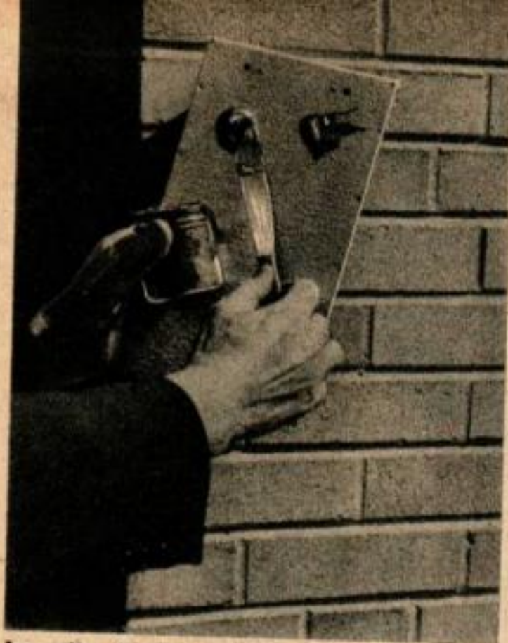
Les colles époxydes peuvent résoudre d'importants problèmes pour un propriétaire de maison, par exemple celui de la fixation d'objets divers sur de la maçonnerie. Ici, la résine époxyde est appliquée sur une boîte aux lettres.
