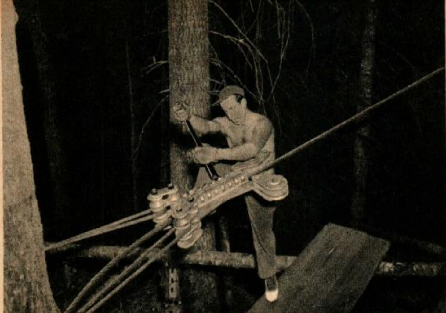
Ce bûcheron serre les boulons du dispositif de serrage qui fixe le câble sur l'arbre d'ancrage. Les troncs d'arbres coupés descendent ensuite le long du câble, ou téléferique.
