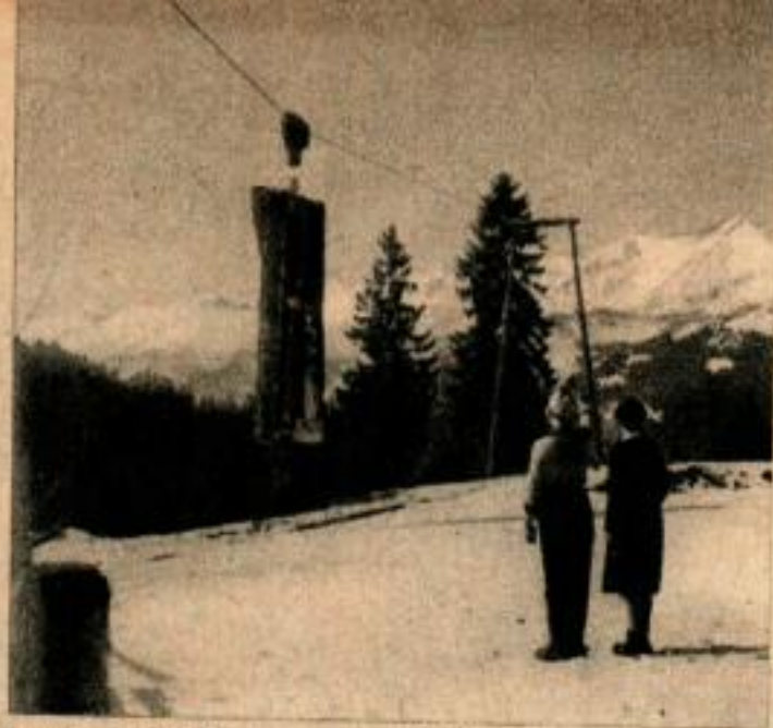
Les troncs d'arbre se rendent à la scierie ou au chantier d'emmagasinement sur cette installation d'essai suisse, laquelle traverse une portion de terrain à niveau.
