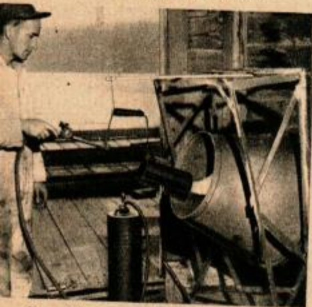
Le sable des machines de nettoyage au jet de sable provient d'un tout proche glacier. Comme il est trop humide, il est préalablement versé dans une bétonnière, dans laquelle il est séché avec un lance-flammes de désherbage.
