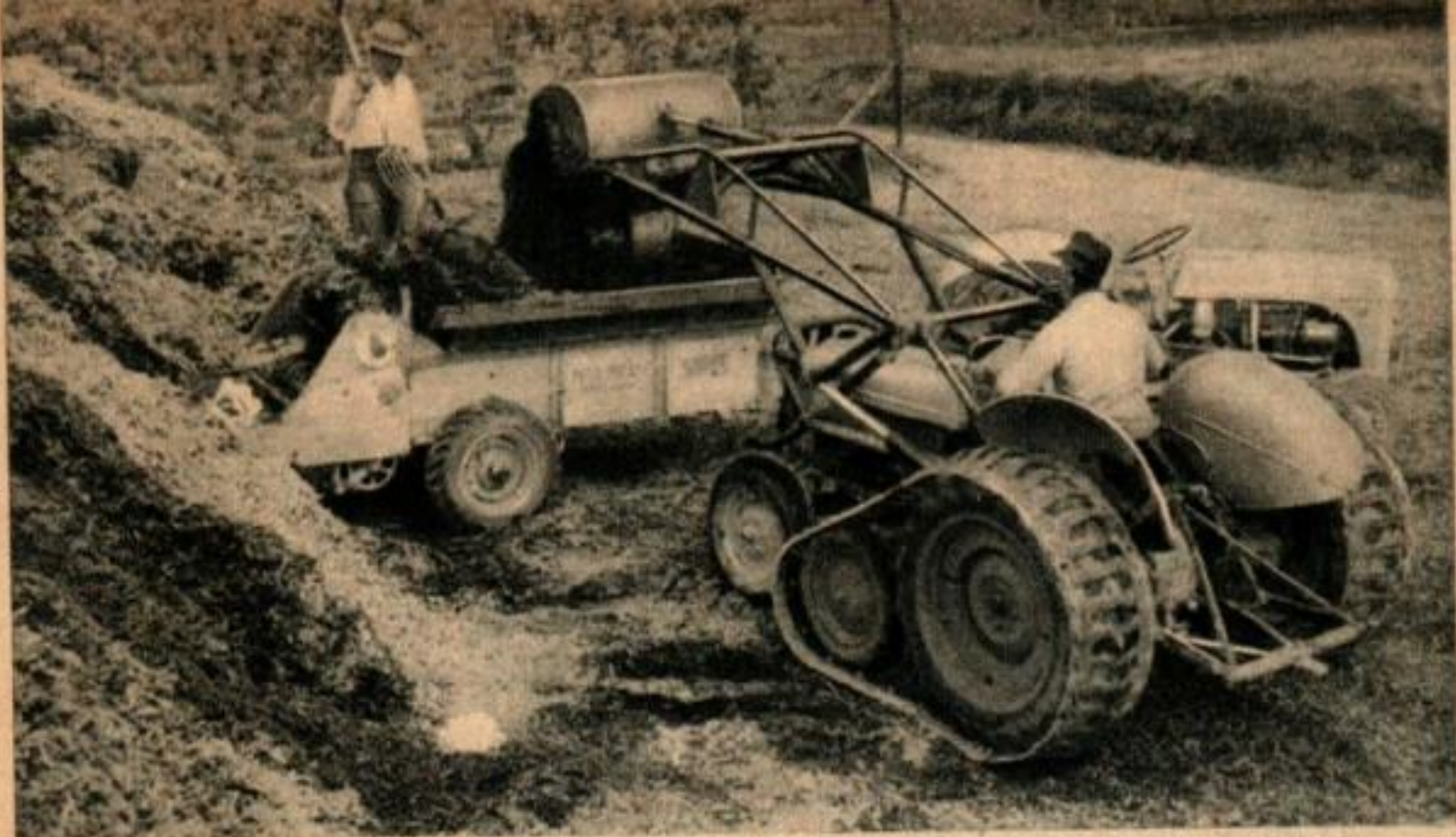
Une pelleteuse à chargement par l'avant creuse dans un énorme tas de copeaux et les dépose dans une épandeuse qui les déposera elle-même en litière dans un vignoble.
